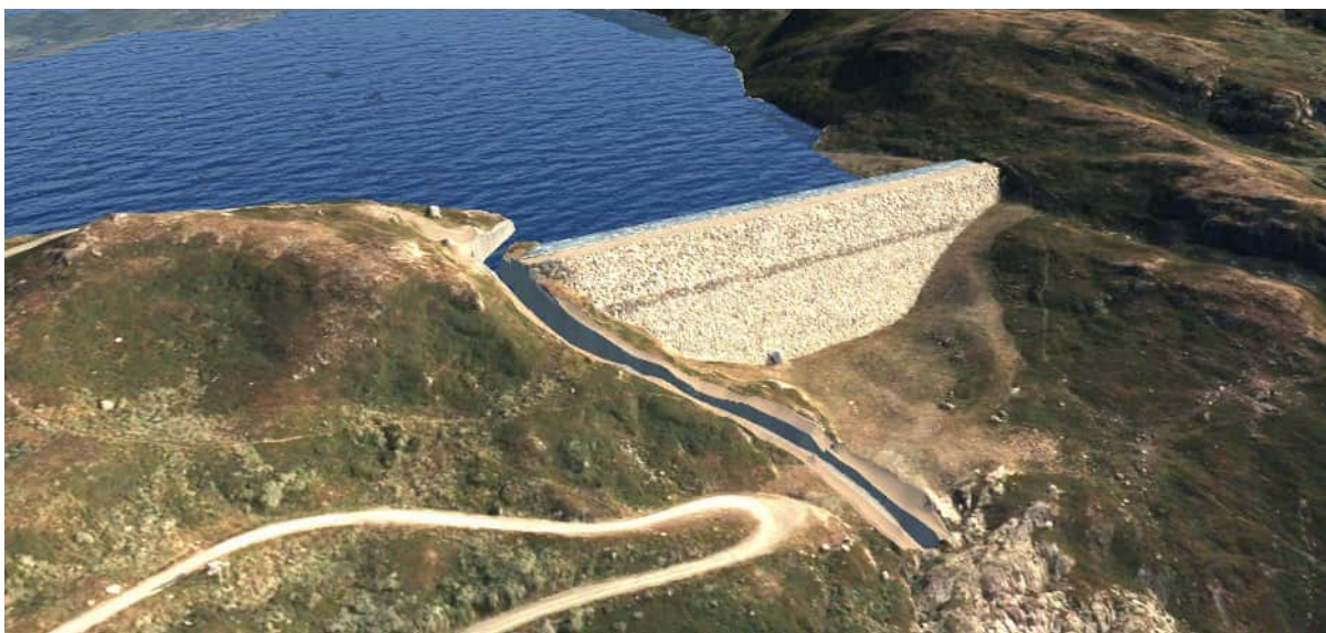
Figur 6 Visualisering nytt flomløp
