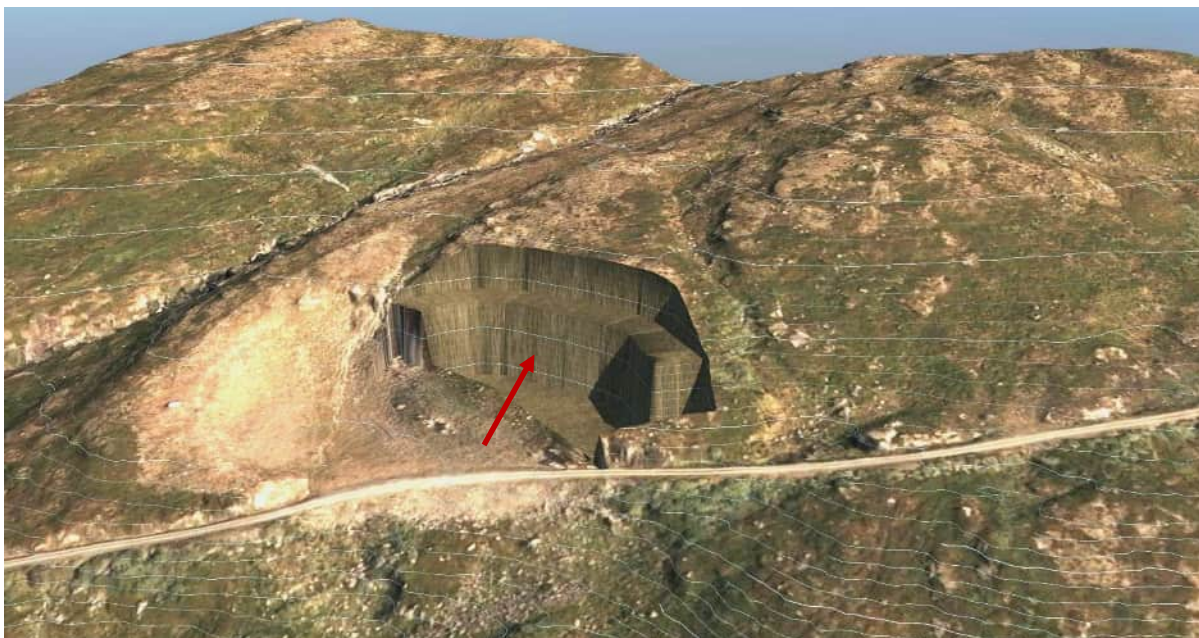
Figur 32 steinbruddet etter uttak av ca. 50 000 \text{fm}^3 . Se også vedlagte steinbruddstegninger (vedlegg 3 & 4). Rød pil markerer uttaksretning.
