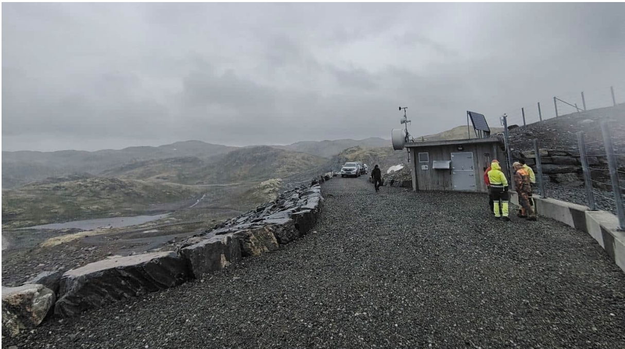
Figur 3-2 Befaring på damkrona ved Kvevatnet.
