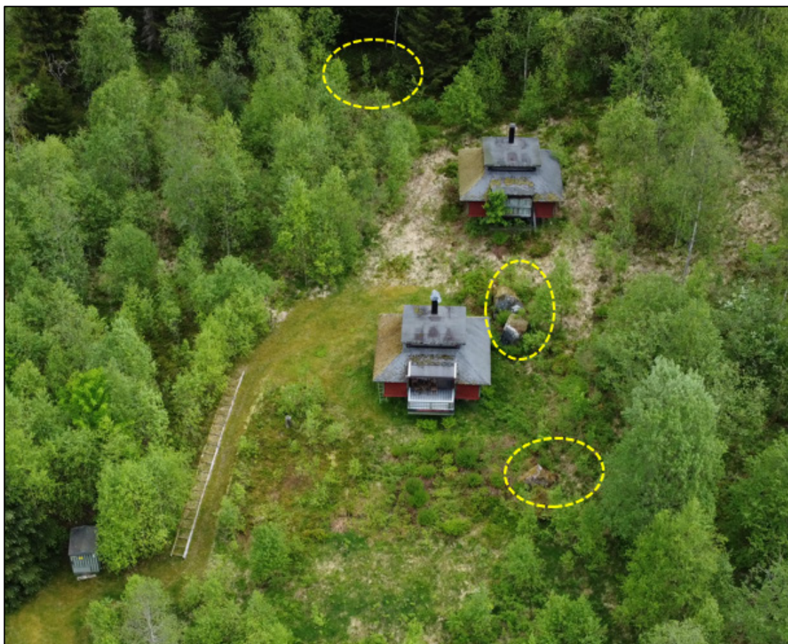
Figur 4-7 Plassering av steinsprangblokker (ca. 3 m 3 ) rundt hyttene lengst nord.
