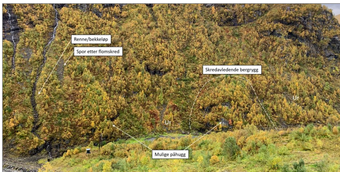
Figur 4-19: Påhuggsområdet for tverrslaget ved Valdalsdammen. Bildet er tatt mot fjellsiden i øst.
