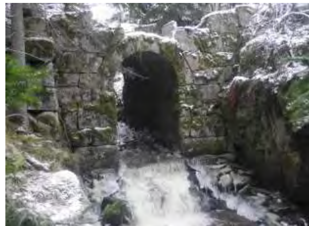
Figur 9 Broen sett nedstrøms fra (bilderetning S). Foto: Ski historielag
