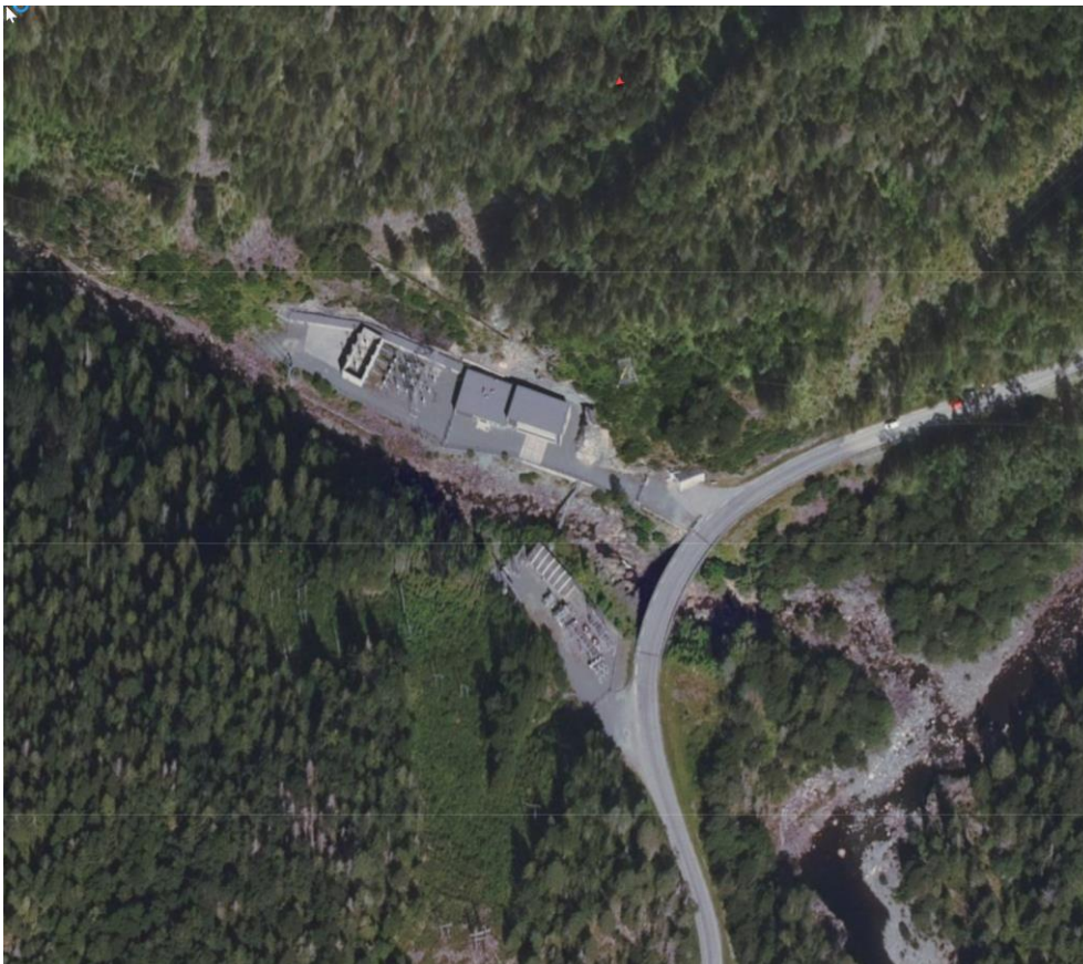
Figur 2 Bilde av koblingsanlegget ved Lio kraftverk
