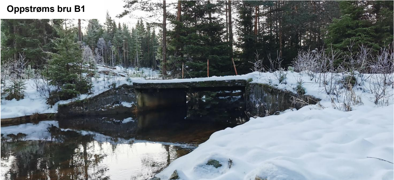
Nedstrøms bru B1
