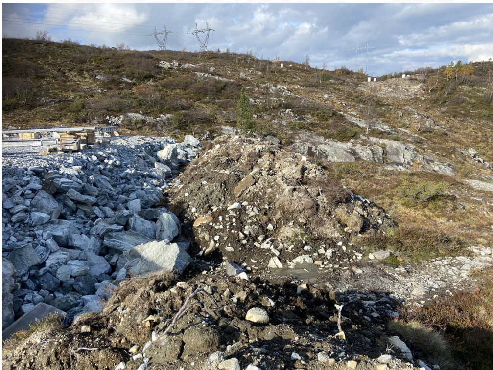
Bilde 11: Mellomlagring av vekstmasser i ranker ved B25a som antakeligvis er for høye sammenlignet med det som er beskrevet og godkjent i detaljplanen. Foto: NVE.
