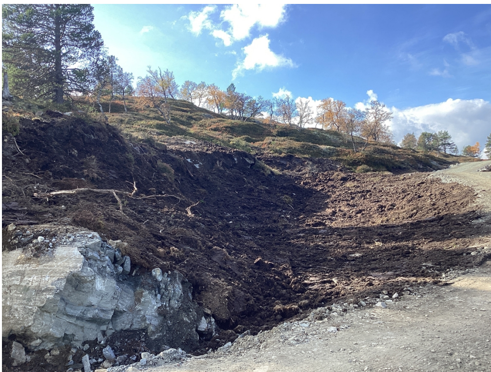
Bilde 2: Eksempel på sidetak langs R9, og som ikke er i tråd med godkjent detaljplan. Foto: NVE.
