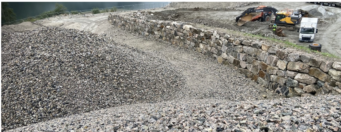
Bilde 19: Etablert rasvull for sikring av stasjonstomta. Foto: NVE.
