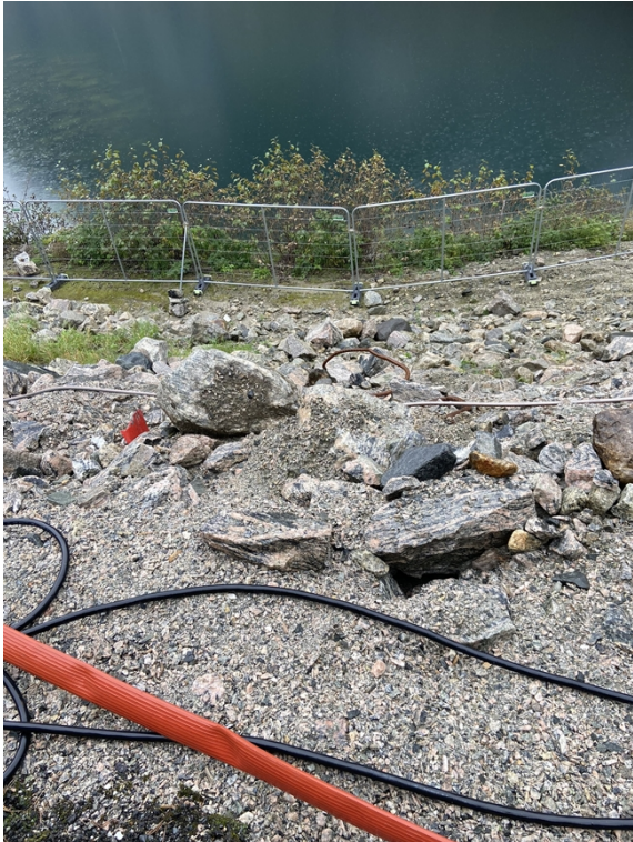
Bilde 17: Steinfylling som må istandsettes som en del av det videre arbeidet. Foto: NVE.
