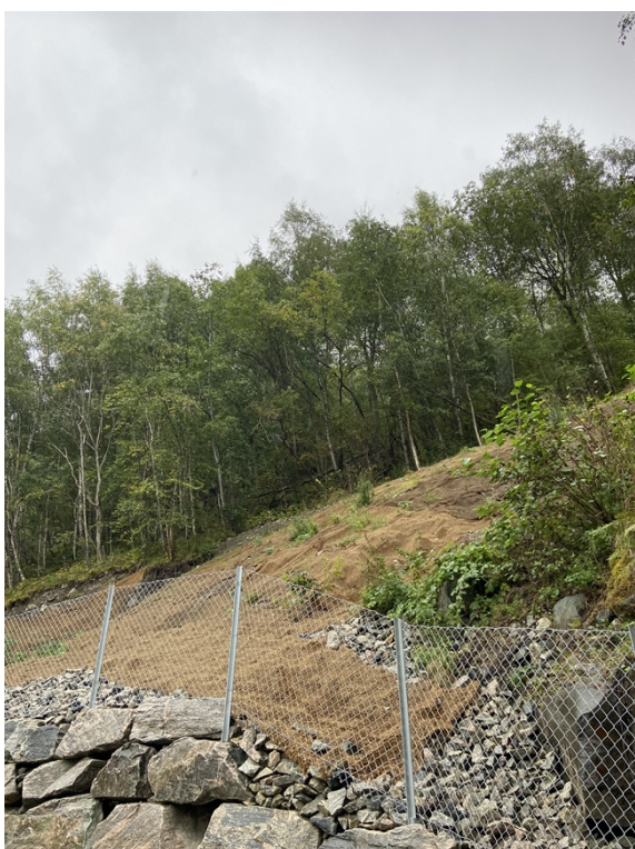
Bilde 20: Kokosmatter i bakkant av stasjonstomta. Foto: NVE.
