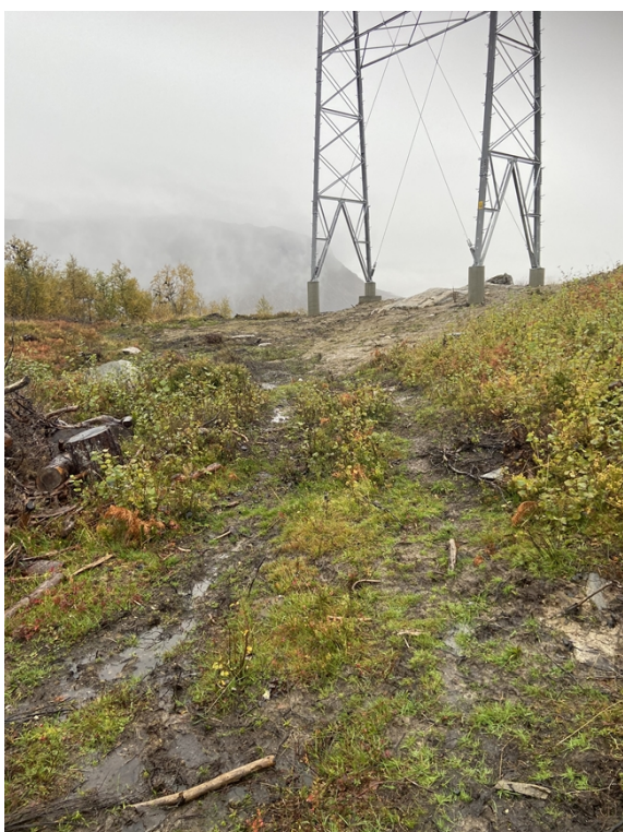
Bilde 15: Også mastepunkt BM207 sør for Sogndal transformatorstasjon mener NVE er opparbeidet på en god måte. Foto: NVE.
