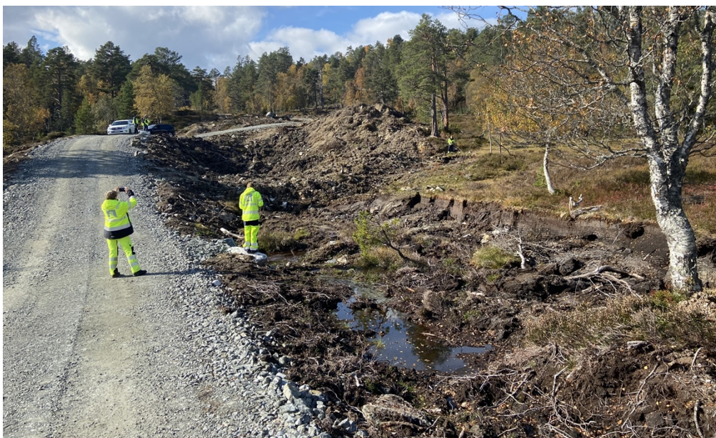
Bilde 5: Omfattende terrenginngrep i myr langs vegen R9. NVE mener det må iverksettes tiltak raskt for å unngå ytterligere drenering av myra. NVE har vurdert dette forholdet som et avvik. Foto: NVE.
