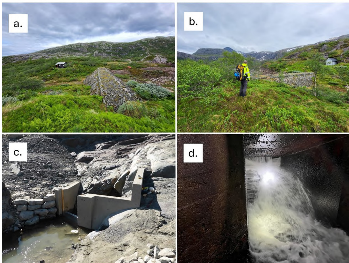
Figur 4. a) Tiltaksområde sett frå sør (ved lukehus) mot nord. b) Tiltaksområde sett frå nord (ved hytte) mot sør. c) Inntak i magasin med bjelkestengsel. d) Eksisterande tappeluke (NB! Dette er i stengd posisjon)
