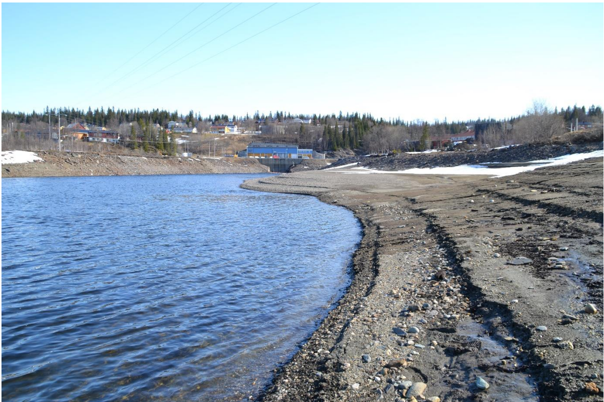
I hele senkingssonen får man noe utglidning av masse som skyldes bølgepåvirkning. Bilde av 11.05.2011.
