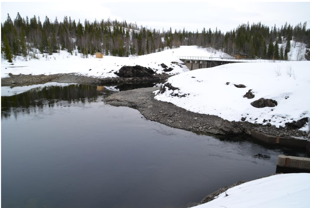
Inntaket i forgrunnen sett fra motsatt side 19.04.2019. Utløpsdammen med luker i bakgrunnen.
