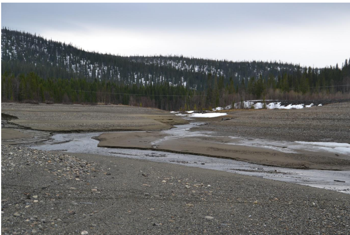
Situasjonen 11.05.2018, sett mot utløpsdammen fra området ved tunnelinntaket. Tilløpsvann fra sidene renner mot sjøen. Det vil være minst 0,5 km fra utløpsdammen til et mulig inntak for pumping av minstevannføring fra magasinet slik topografien er mot utløpet. Vannstand 410,21, LRV + 121 cm.
