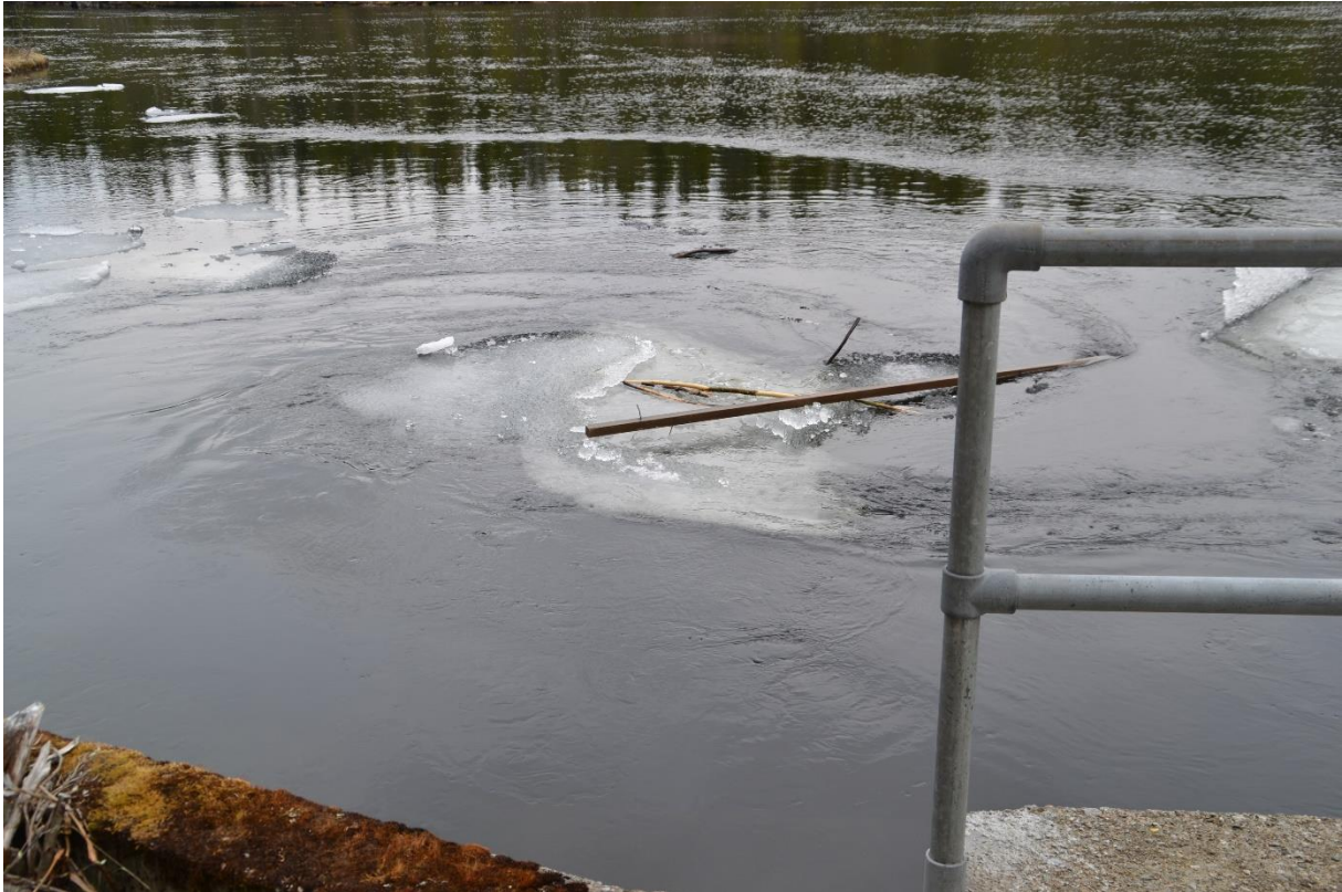
Det er ingen form for avskjerming mot terrenget til høyre for tunnelinntaket. Bilde av 22.05.2018.
