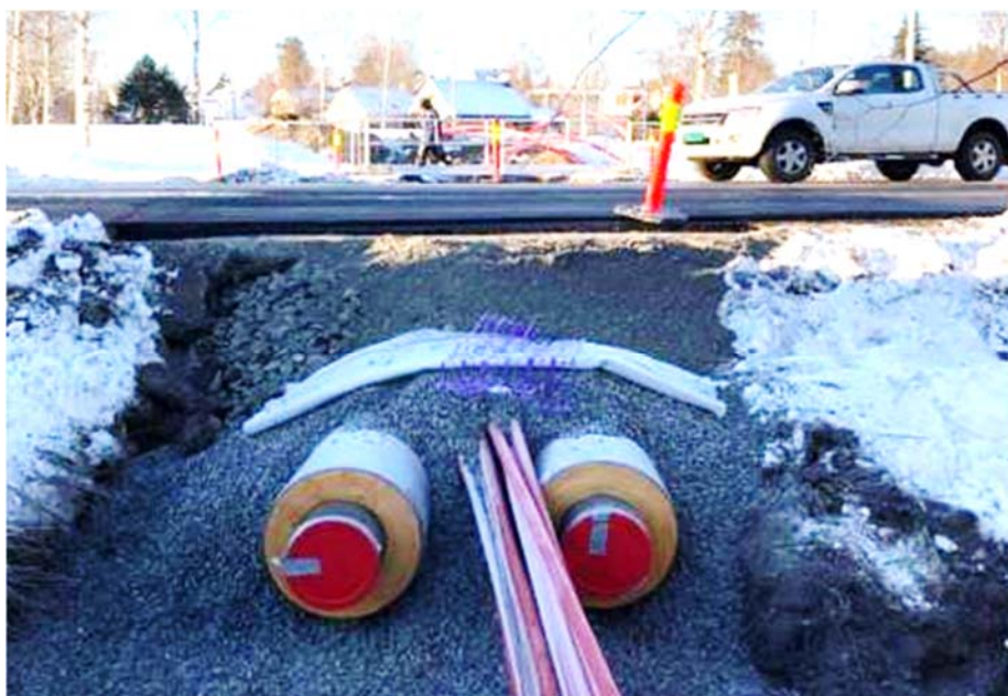
Figur 3, Fjernvarmerør
