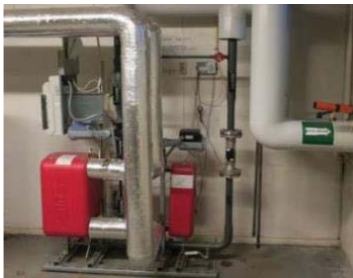
Figur 1, Eksempel på kundesentral med veksler for varmt tappevann og oppvarming.
