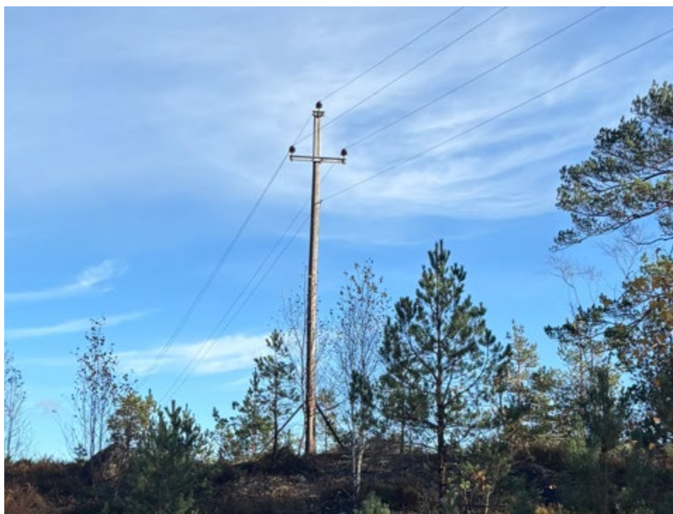
Bilde 1: Typisk utforming av bæremast
