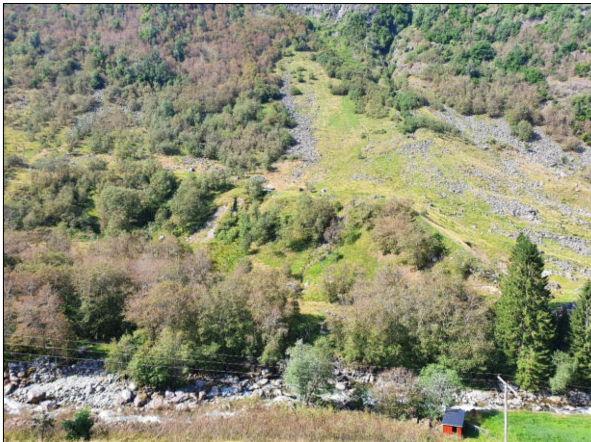
Figur 18: Fotografiet viser mindre utrasingar i lausmasseskråninga ned mot Kandalselva, i tillegg til ur i nedre delar av fjellsida.
