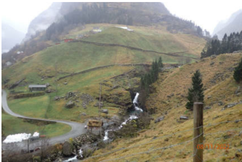
Bilde 1, nedlagt kraftverk med stasjon (nå; ysteri) og rørgate i dagen
