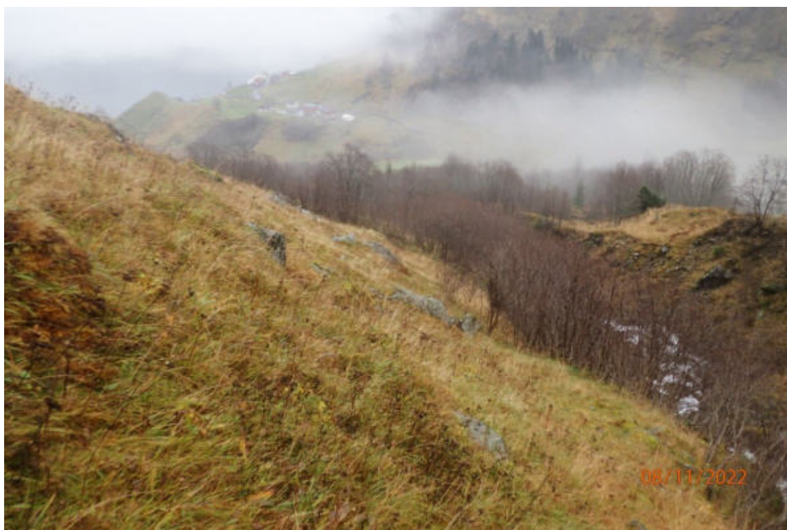
B6, rørtraseen like nedstrøms inntaket
