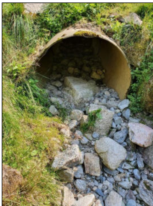
Figur 24: Gjennomføring i nedre delar av fjellsida aust for Kandalselva. Bekkeløpet har transportert lausmassar når det er vassføring i løpet.
