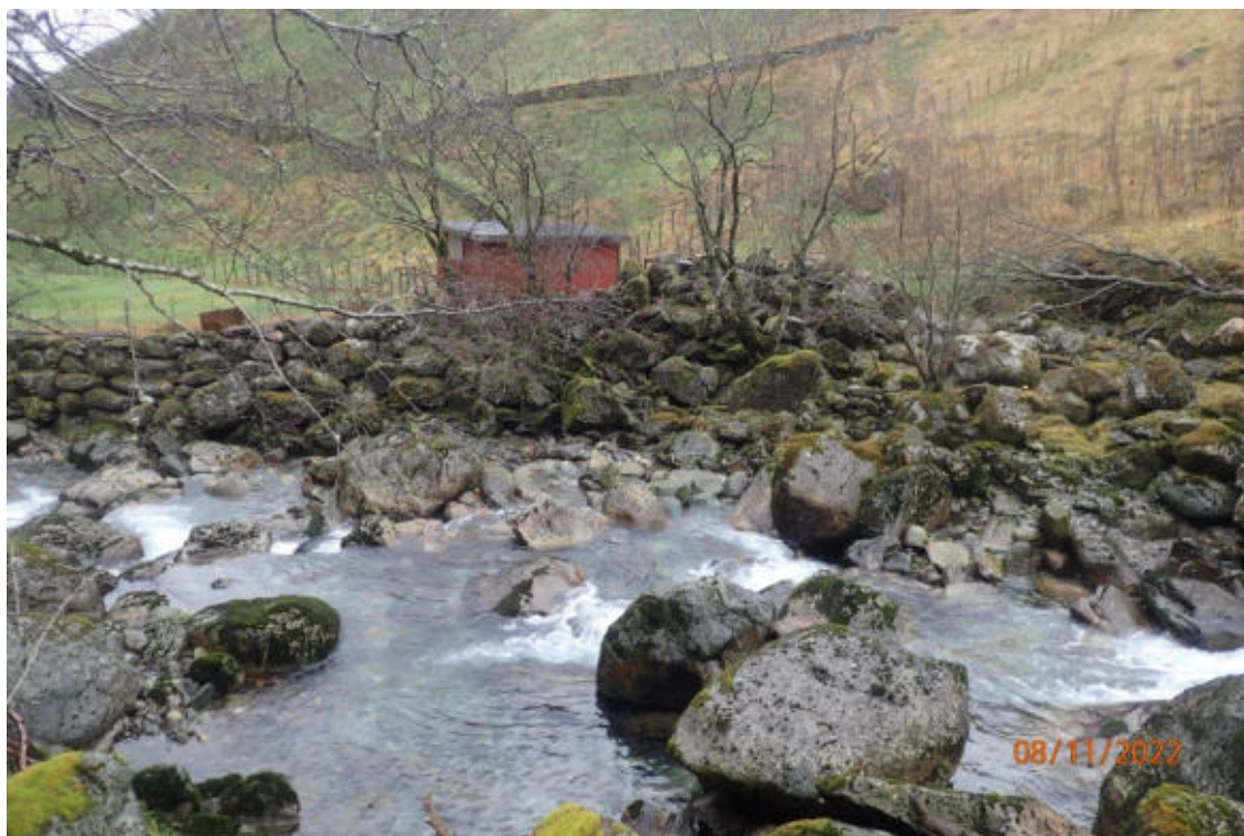
B18, utslippspunkt fra kraftstasjonen i Kandalselva
