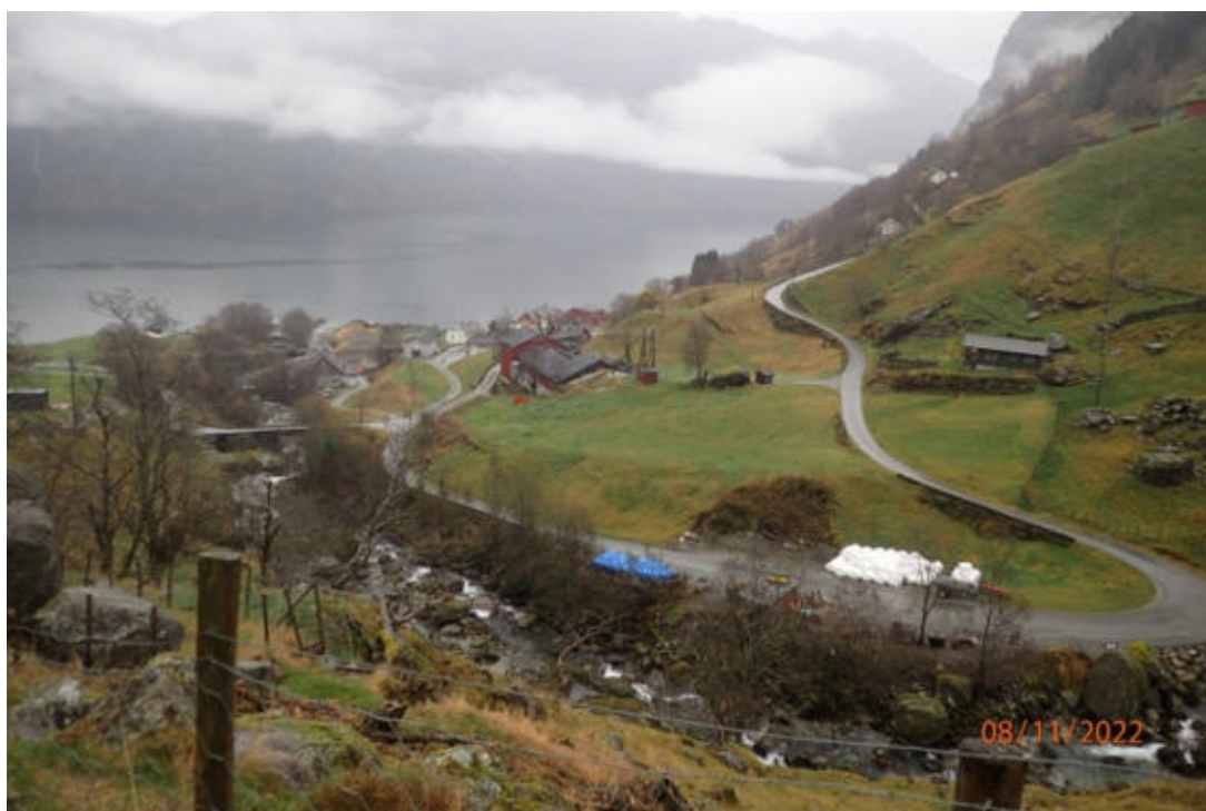
B26, tilknytningspunkt HS-kabel ved 22 kV nettstasjon/stolpe midt på bildet
