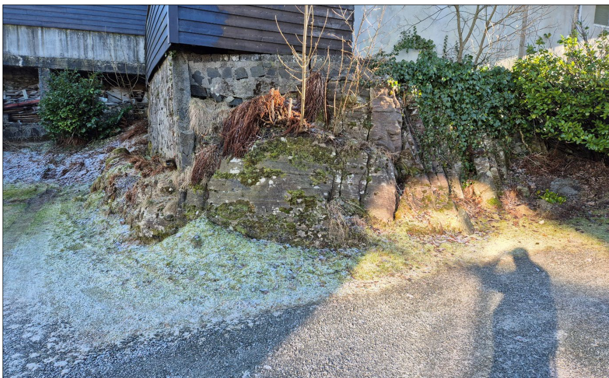
Figur 19: Fotopunkt 7, bolig fundamentert på fjell nord for tiltaksområdet, langs kritisk skråning 1. Foto: SGC.
