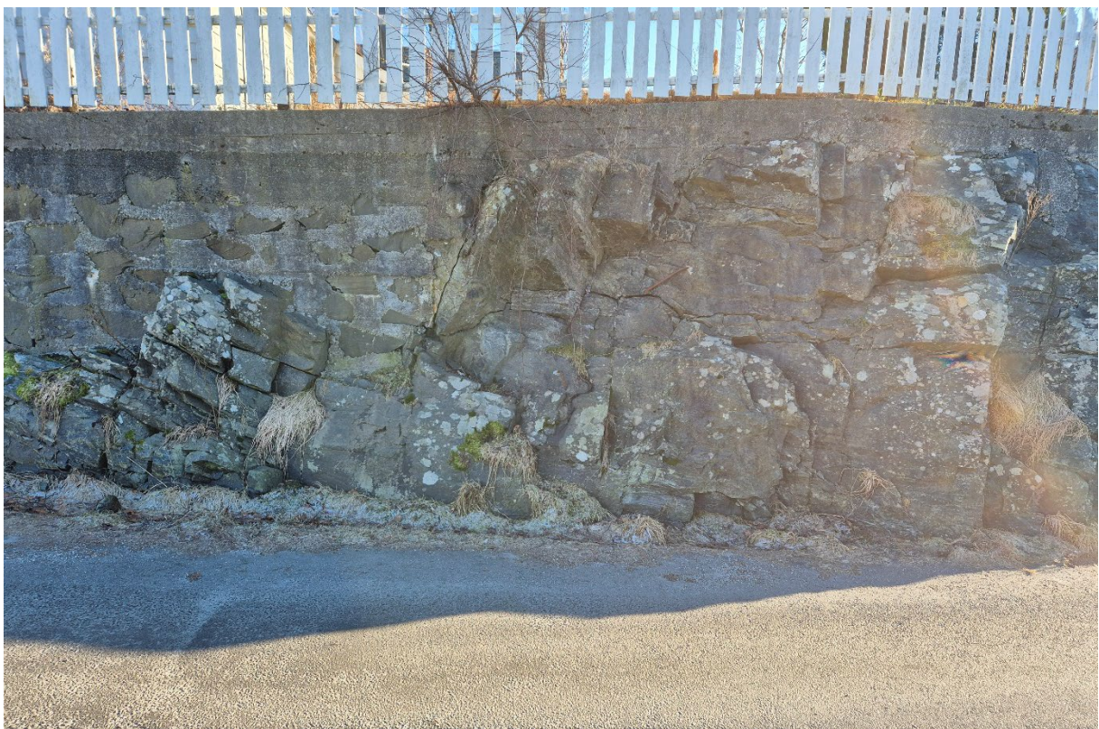
Figur 12: Fotopunkt 2, skjæring langs Stasjonsvegen, nordøst for tiltaksområdet. Foto: SGC.
