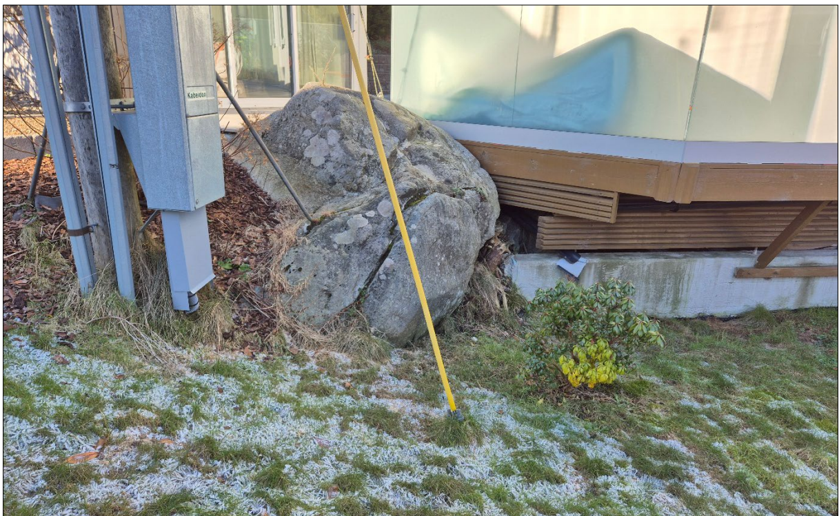
Figur 18: Fotopunkt 8, fjell i dagen nord for tiltaksområdet, langs kritisk skråning 1. Synlig utsprengt fjell innenfor grunnmuren. Foto: SGC.
