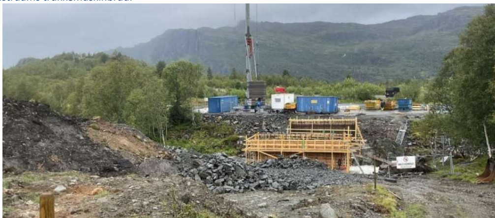
Figur 1-10 Ny bru over Storelva 200 m nedstrøms dammen i Stølselva. Bygd i 2024 av Statens Vegvesen. Brua ligg 65 m nedstrøms trakkemaskinbrua.
