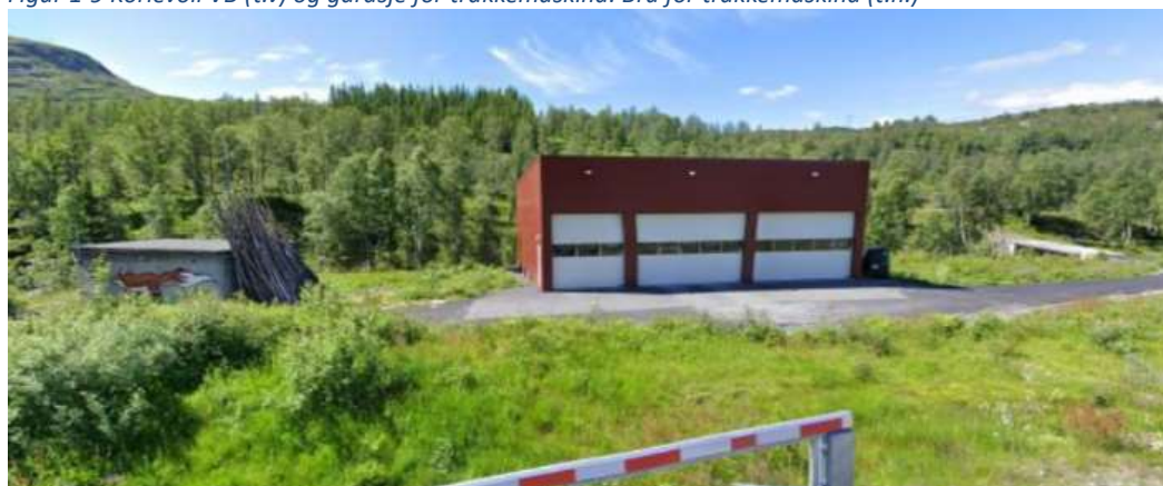
Figur 1-9 Korlevoll VB (t.v) og garasje for trakkemaskina. Bru for trakkemaskina (t.h.)
