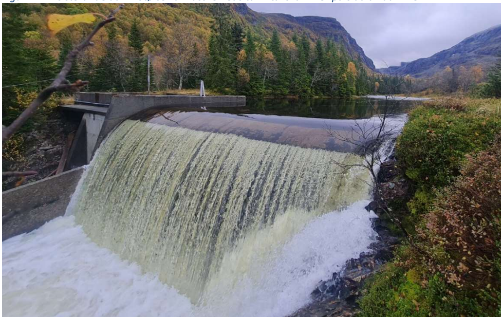
Figur 1-1 Eksisterande dam i Stølselva. Vassverket sitt inntakskammer på sida av dammen.
