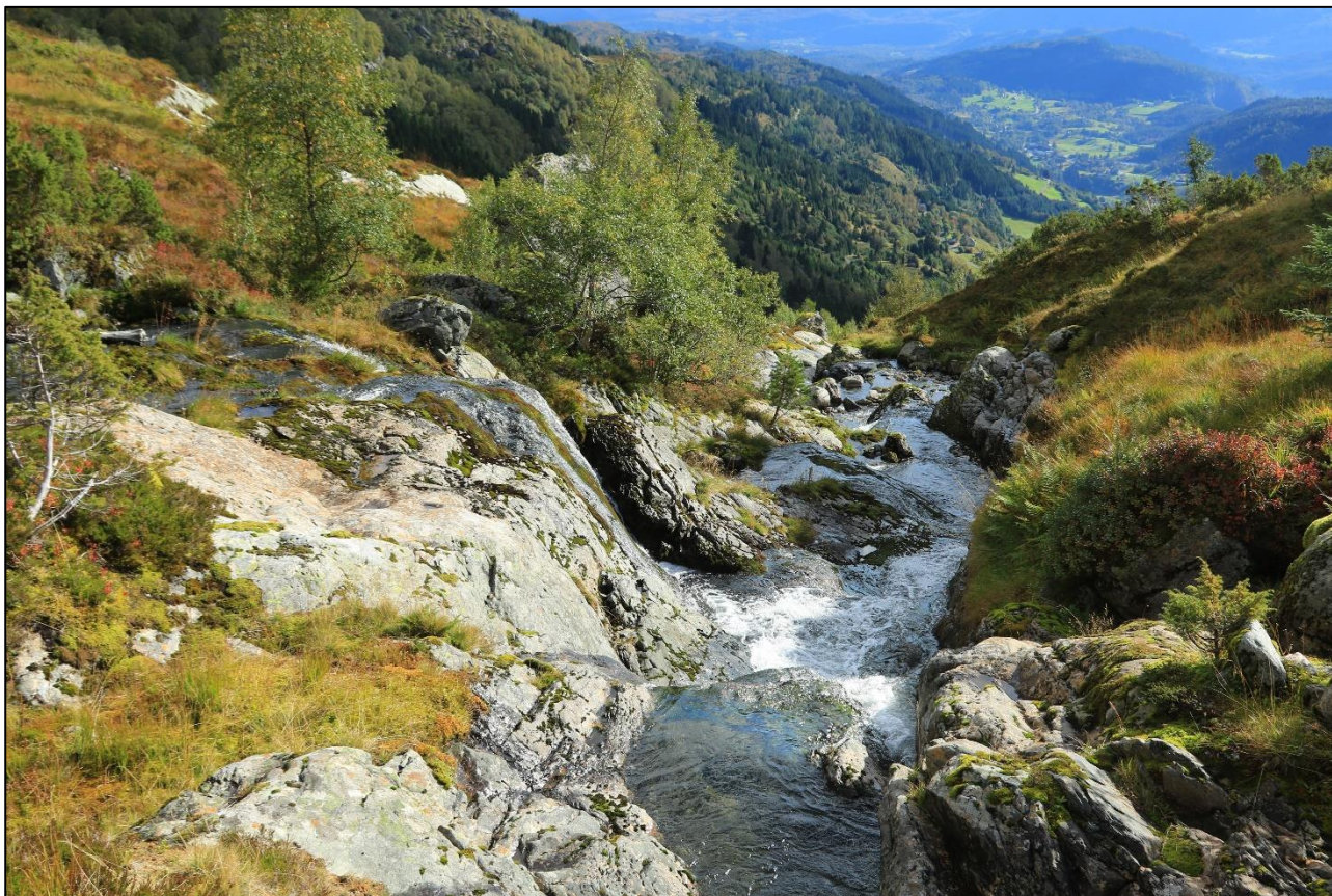
Inntaksområdet ved samløpet med bekken fra nord, sett ovenfra.
