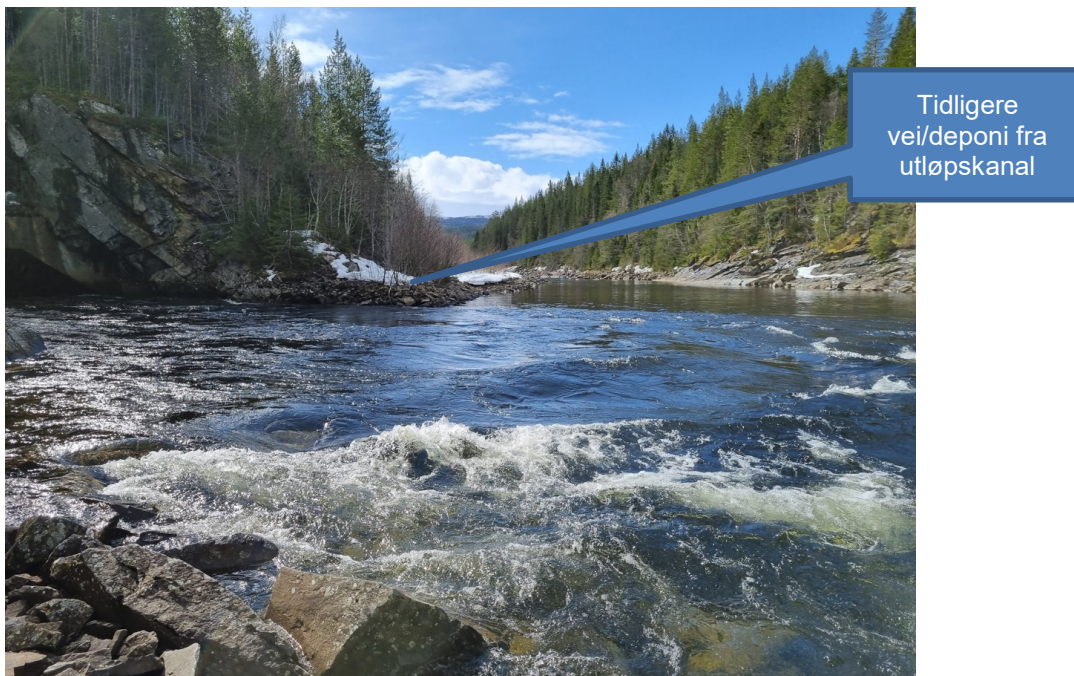
Figur 7: Fra nedstrømside av utløpskanalen. På motsett side ser man starten på tippet fra byggingen og tilkomstveien.
