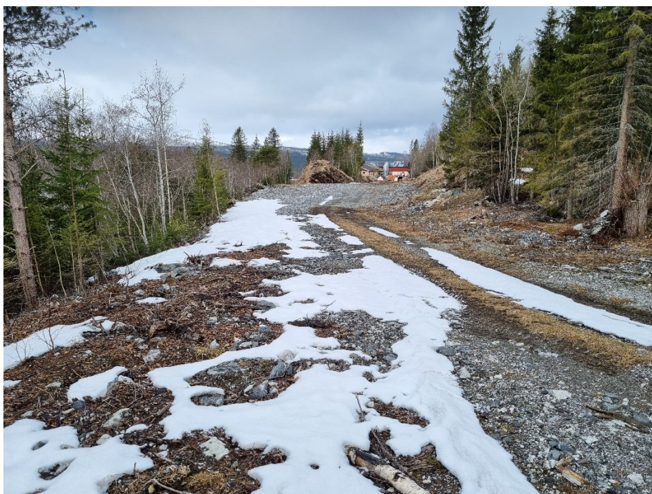
Figur 10: Deponiområde i øvre tiltaksområde. Deponi fra kraftutbygginga og blir brukt som alternativ tilkomstvei for gårdsbruk. Veien/terrenget her kan heves uten særlige påvirkning på naturverdier.
