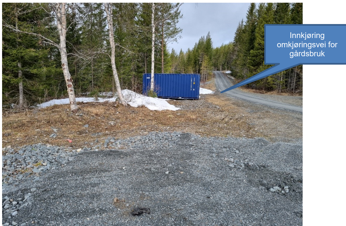
Figur 11: Riggområde ved inngang kraftstasjon. Skog bak kontainer ryddes mot steindeponi.
