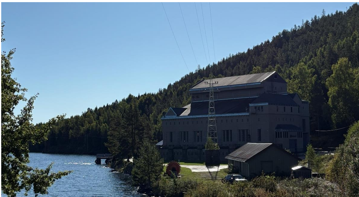
Figur 0-17: Hakavik kraftverk sett fra mast 2, Hakavik-Sundet. Mast 1 står på tunet til kraftverksområdet.
