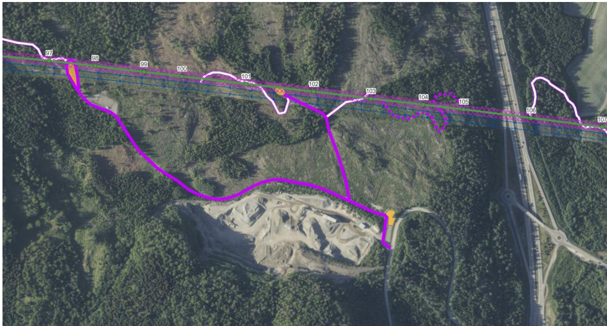
Figur 0-27: Flyfoto av aktivt pukkuttak på Hanekleiva, vest for E18. Eksisterende veier og opparbeidede plasser planlegges benyttet for adkomst (lilla) og rigg (oransje felt).
