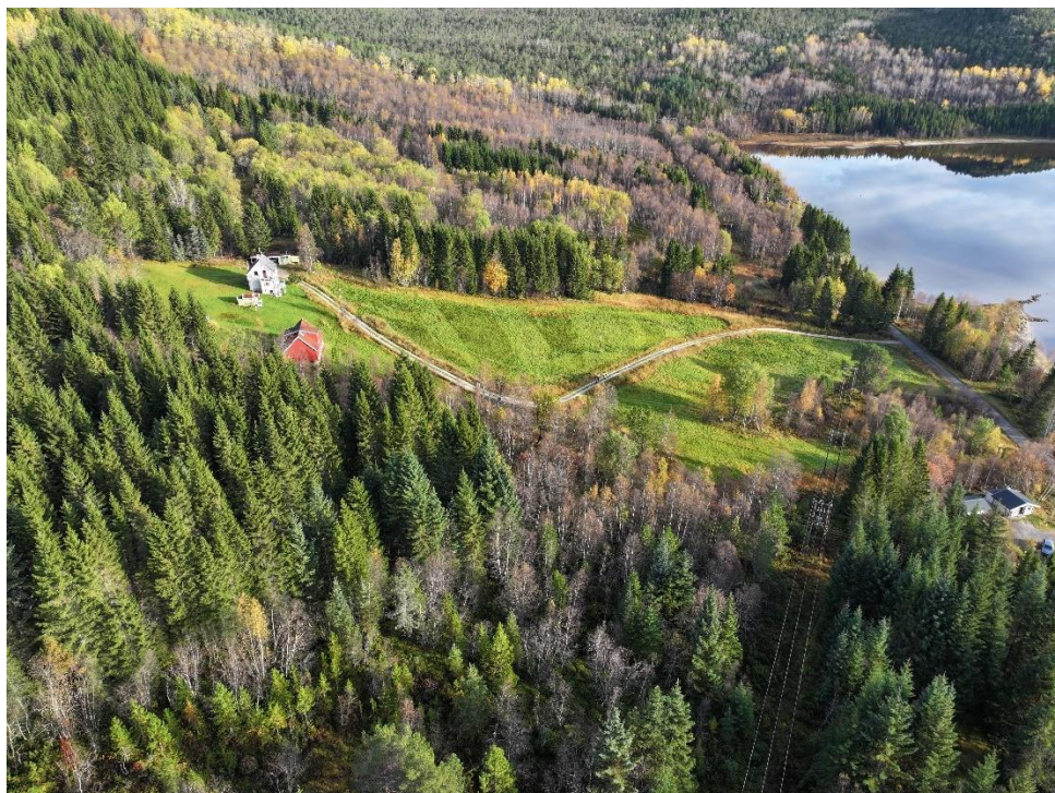
Figur 8-27. Dronefoto som viser dagens 22 kV-ledning (til høyre i bildet). Ny ledning er tenkt å plasseres i området som ligger ca. i midten av bildet. Det definerte delområdet ligger skjult i skogen, lengre nord for det hvite huset.
