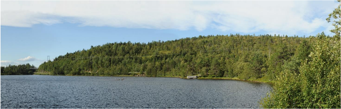
Figur 3-19. Dagens situasjon ved Jensvatn. Bildet viser eksisterende 22 kV-ledning som går langsmed E6 og vannet.
