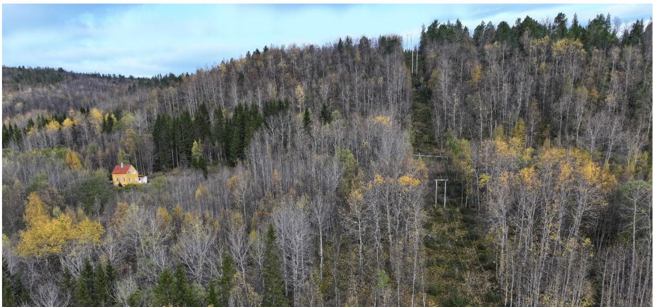
Figur 3-18. Eksisterende 22 kV-ledning som krysser E6 og føres videre over Aksla. Ny ledning vil gå på venstre side av 22 kV-ledningen, og føres nærmere Fjellstad (gule huset i bildet).
