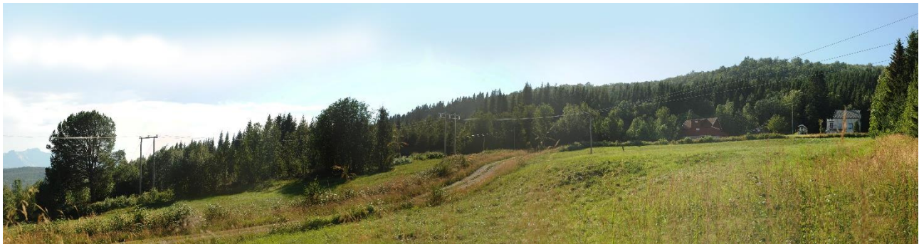
Figur 3-14. Fotomontasje av ny situasjon ved Solli gård. Ny 66 kV i midten av bildet. Større bildeformat er vist i eget vedlegg til rapporten.
