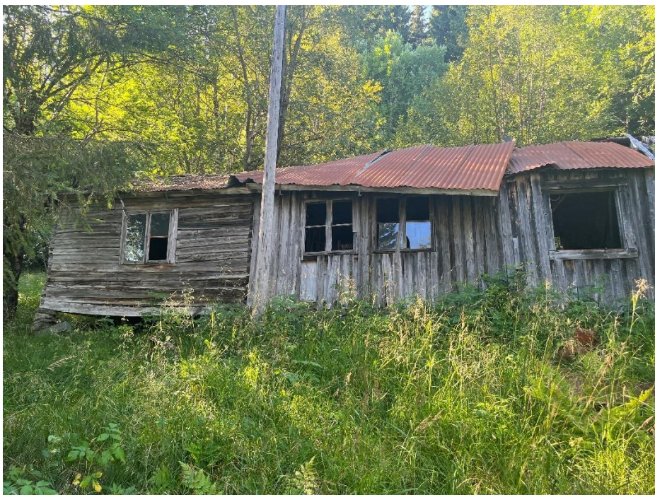
Figur 8-5. Snekkerverksted, maskinverksted og smie i ett og samme bygg.
