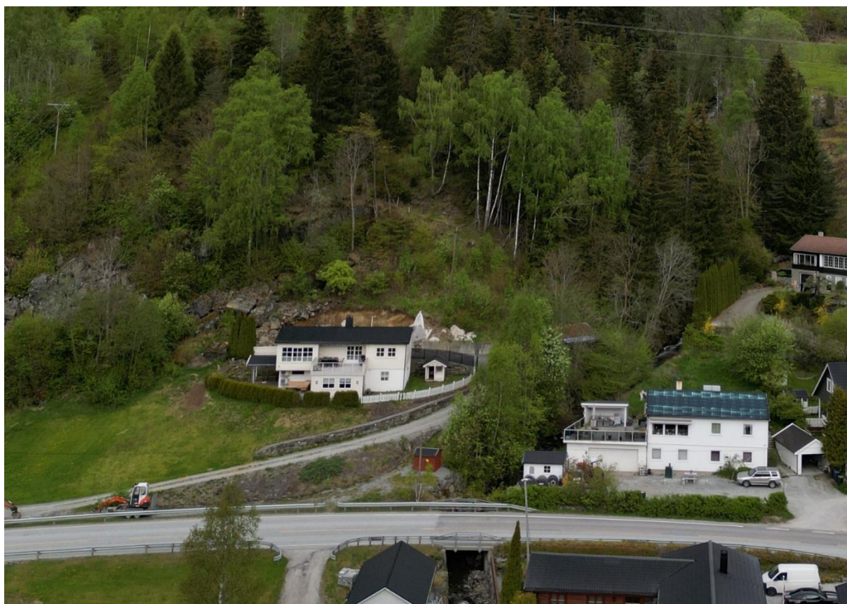
Figur 5: Dronebilde tatt mot vest. Bolighuset på kartleggingsområdet er det hvite huset til venstre i bildet. Skrent ses bak og til venstre for bolighuset.
