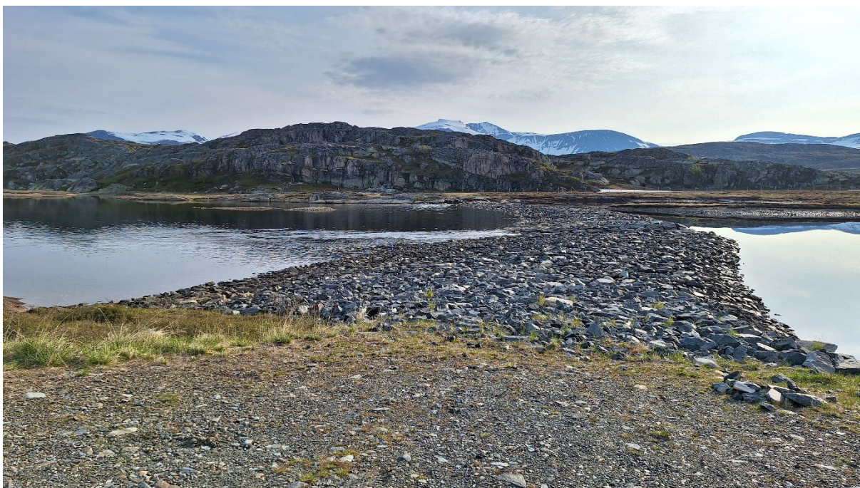
Fig. 7: Terskeldemningen sør i Falksjøen, som ligger litt nord for grensa til Sverige. Foto tatt rett sør for tellepunkt 3. Kanalen gjennom terskelen har laveste punkt på kote 824,5.
