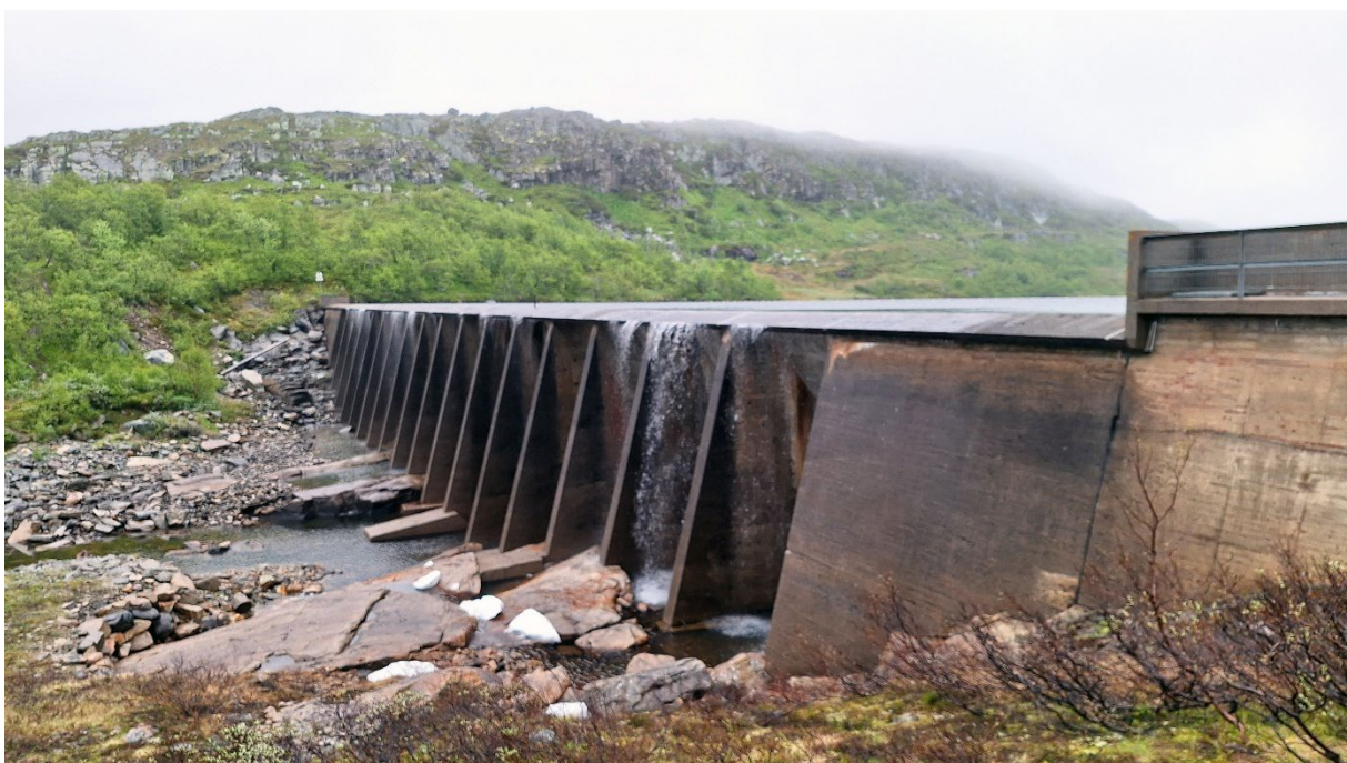
Fig. 5: Demningen på Falksjøen er en 130 m lang betongdam med overløp på nesten hele bredden. Største høyde er på 12 m.
