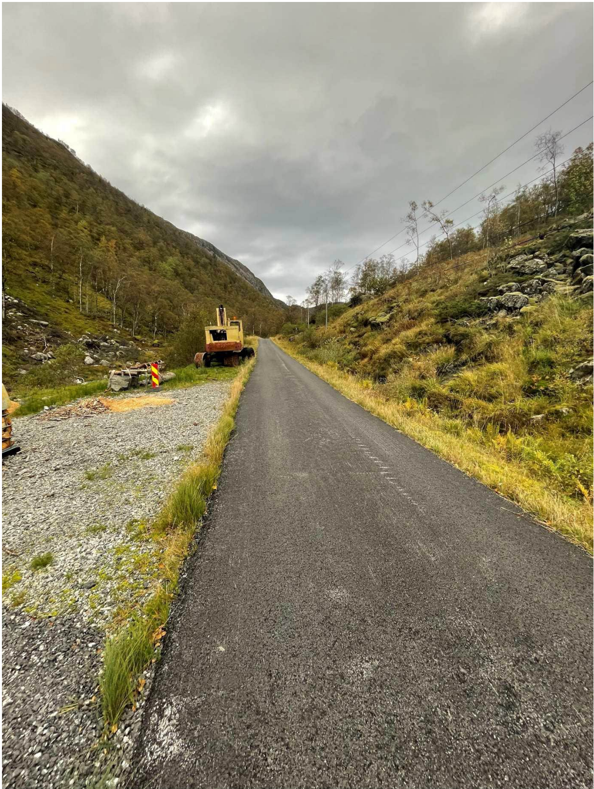
Langs vannveien (kommunal vei), R3 til venstre i bildet
