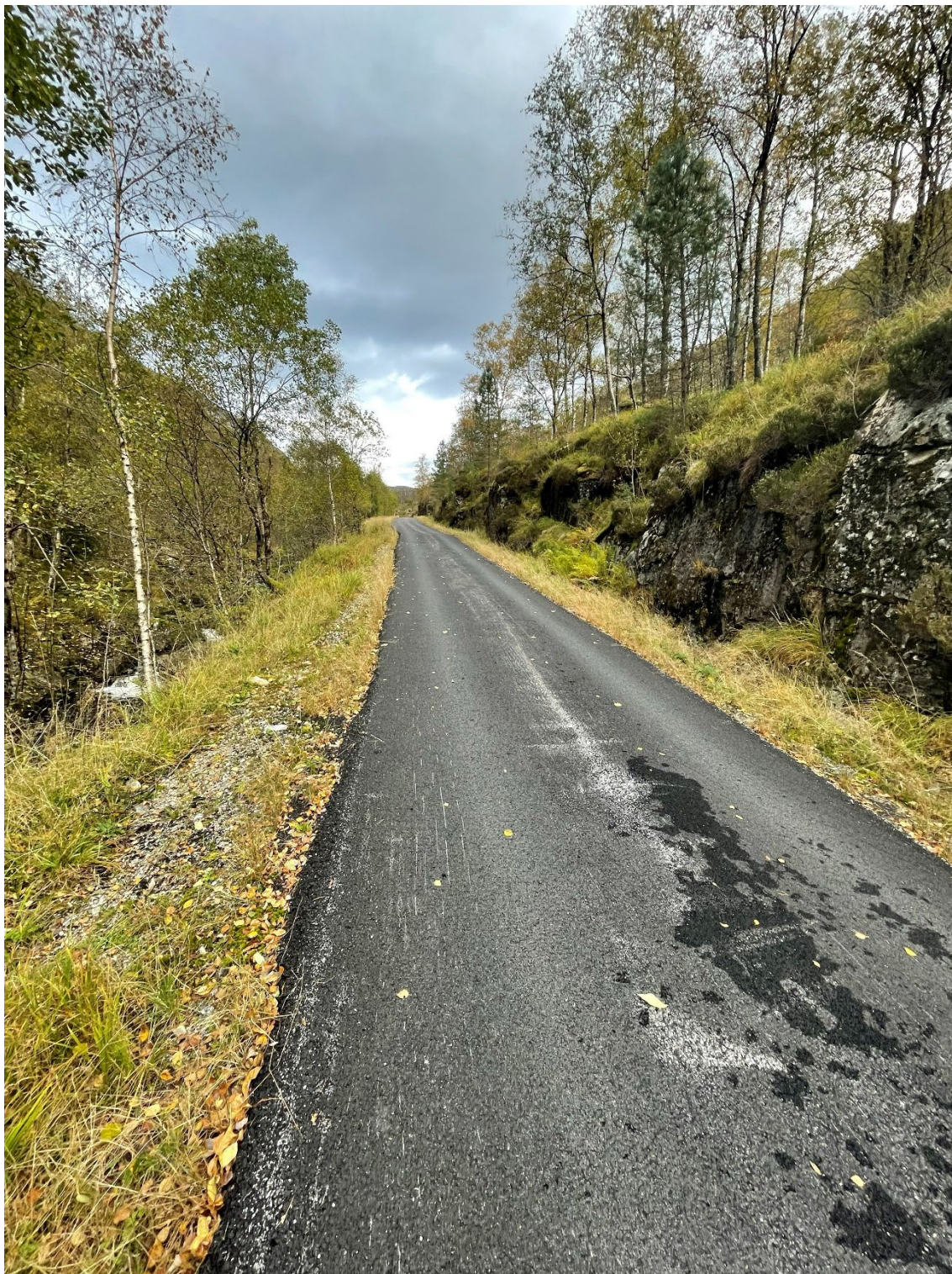
Figur 23, typisk terreng langs den kommunale veien; fjellskjæring med varierende høyde mot øst, Fossdalselva like vest for veien
