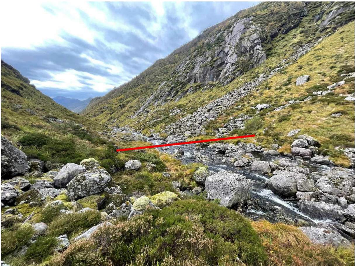
Inntaksområde i Fossdalselva, sett fra oppstrøms side. Rød strek angir ca plassering av terskel
