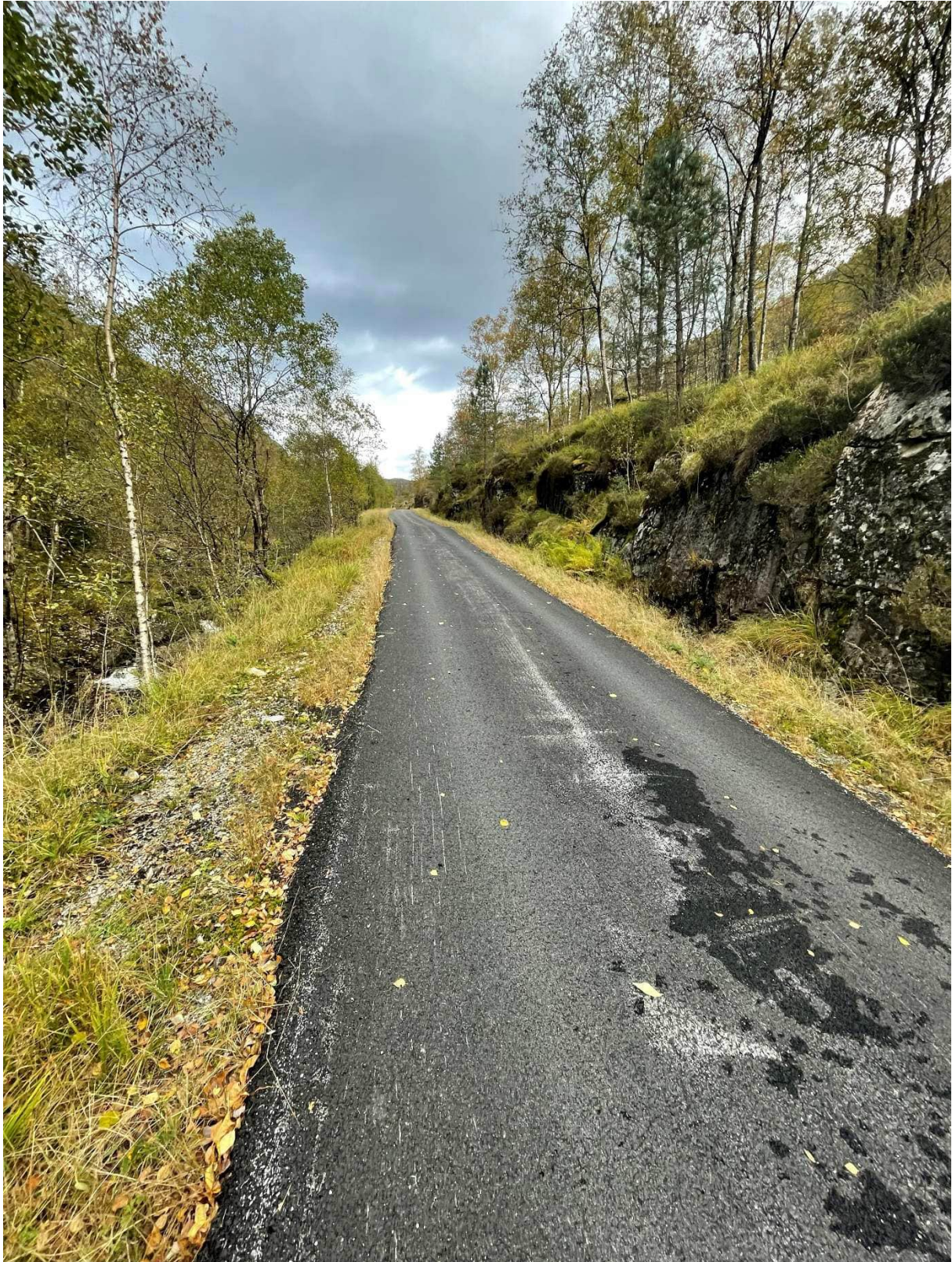
Typisk terreng langs kommunal vei. Nærhet til elven på vestsiden (venstre side) av veien, skjæring med varierende på østsiden (høyre side) av veien.
