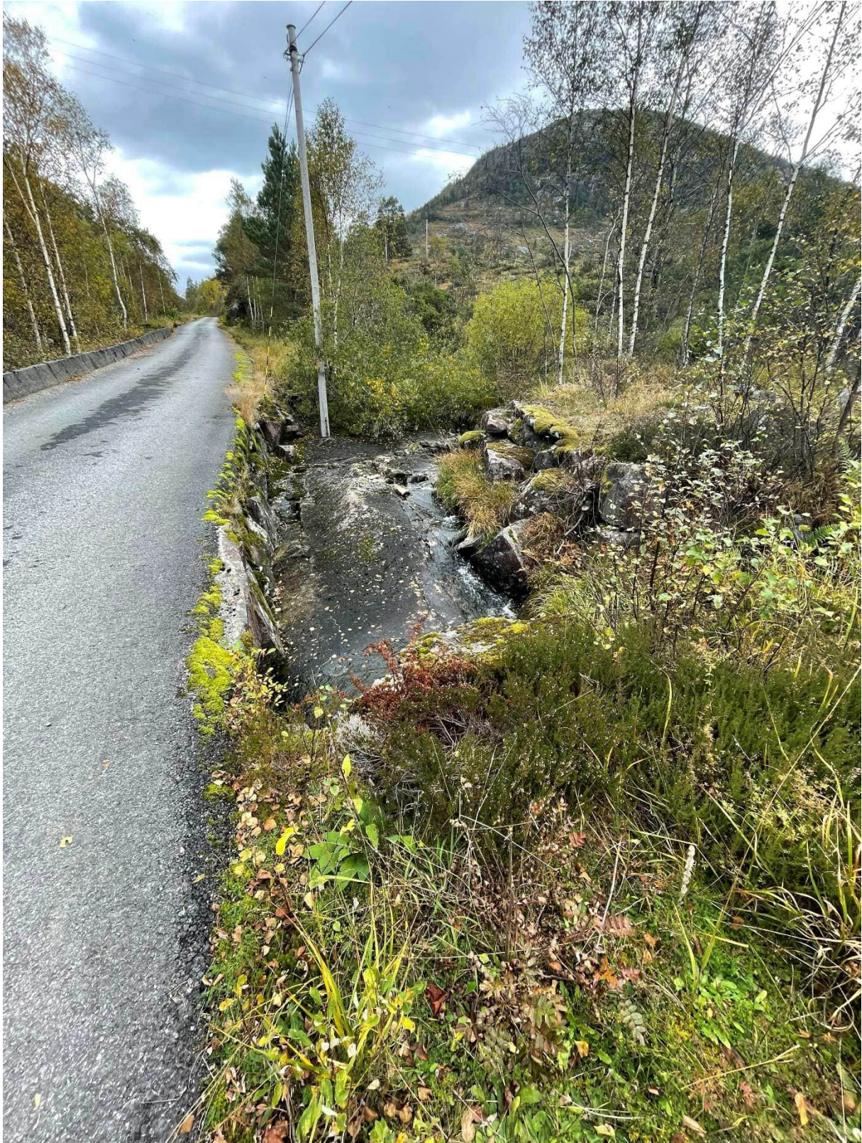
Flere stikkrenner krysser den kommunale veien, disse vil bli hensyntatt ved etablering av vannvei (grøft)
