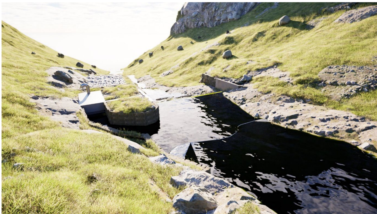
Bilde 2, fotomontasje av inntak, sett fra nord (oppstrøms side)
