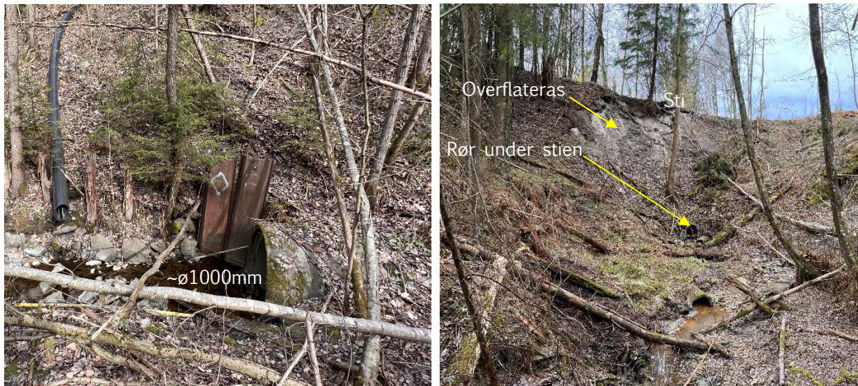
Figur 3. Bilde fra befaring. Rørlagt bekk ved Kjellemovegen (t.v.) og under stien (t.h.).
