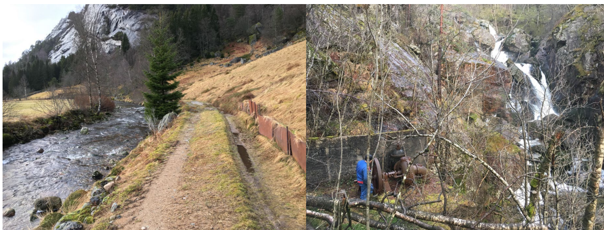
Fig.2: Venstre: Fra jordbruksområdet oppstrøms inntaket. Høyre: Fra øvre del av fallstrekningen (Foto: Småkraftkonsult)
