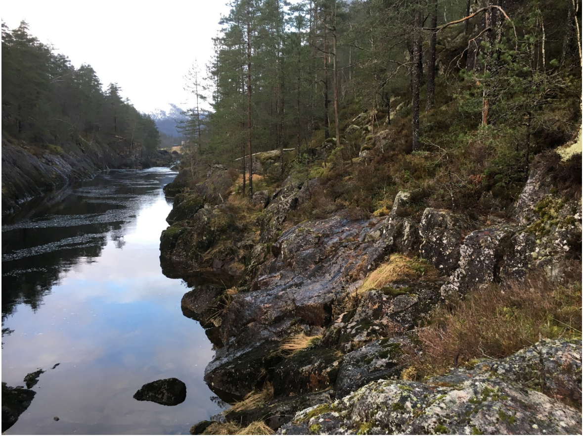
Fig.5: Kraftstasjonsområdet i høyre billedkant
