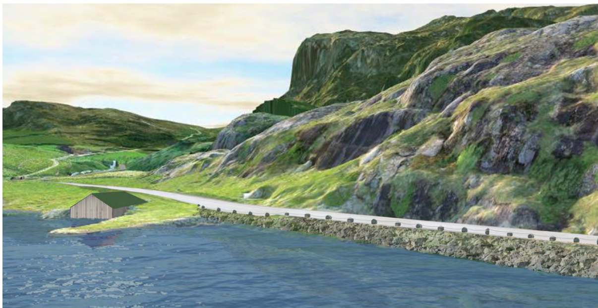
Figur 28: Fylling i Birkelandsvatnet, skråning og eksisterende båthus
