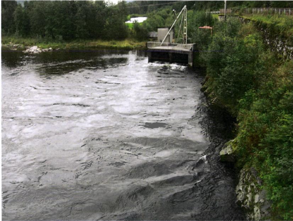
Figur 9: Kraftverksutløpet ved Harang som forsinker og avleder oppvandrende fisk
