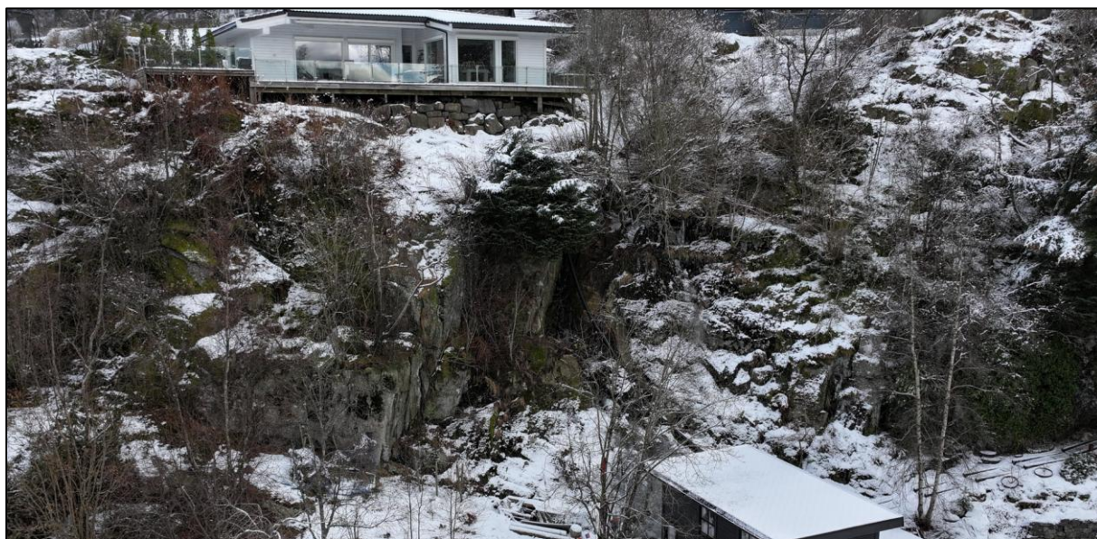
Figur 9: Dronebilete av påverknadsområdet viser at store delar av skråninga er blottlagd fjell, og at det berre er eit tynt lag av organisk materiale der det er lausmassar.
