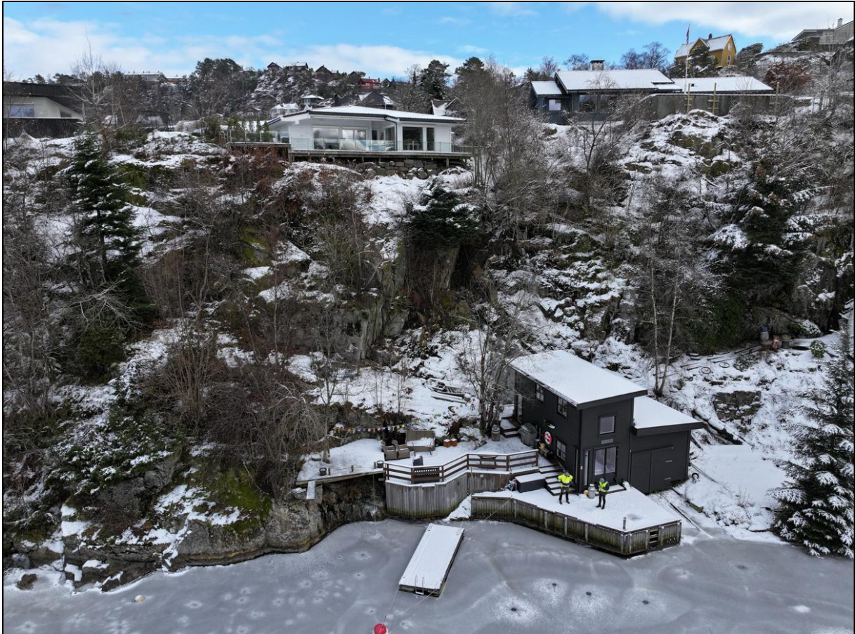
Figur 2: Dronebilete som viser kartlagt område (naust og kai), og påverknadsområdet (fjellskrånninga) i bakkant. Bilete tatt mot aust.
