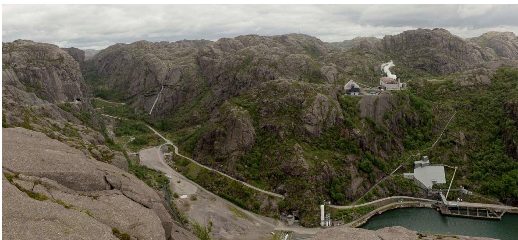
Figur 13. Bildet er tatt fra vestsiden av Jøssingfjord og viser bl.a. Titanias tørkeanlegg og bakomliggende areal hvor tiltak er planlagt. Landskapet er svært kupert.
