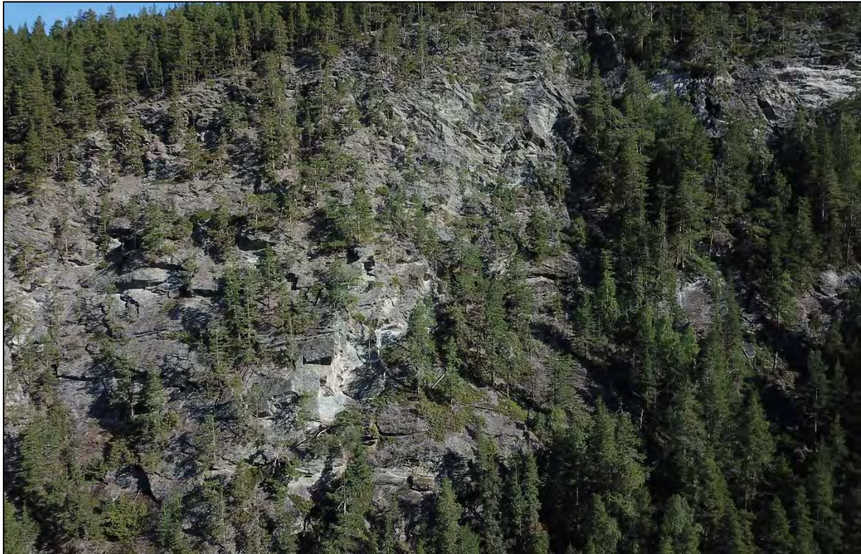
Figur 15: Dronebilde av løseområde over område B og C, som viser de dominerende sprekkesystemene for berggrunnen i området.
