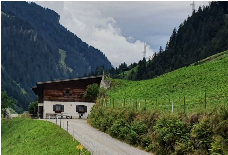
Figur 22: Eksempel på bygg som er bygd inn i en skråning slik at snøskred kan passere over taket. Foto: Skred AS
