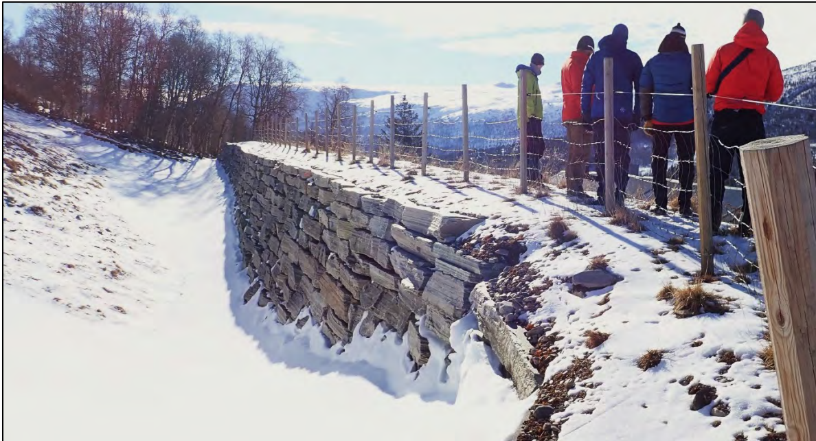
Figur 21: Eksempel på voll med bratt støtside bygd som en tørrmur av store steinblokker.
