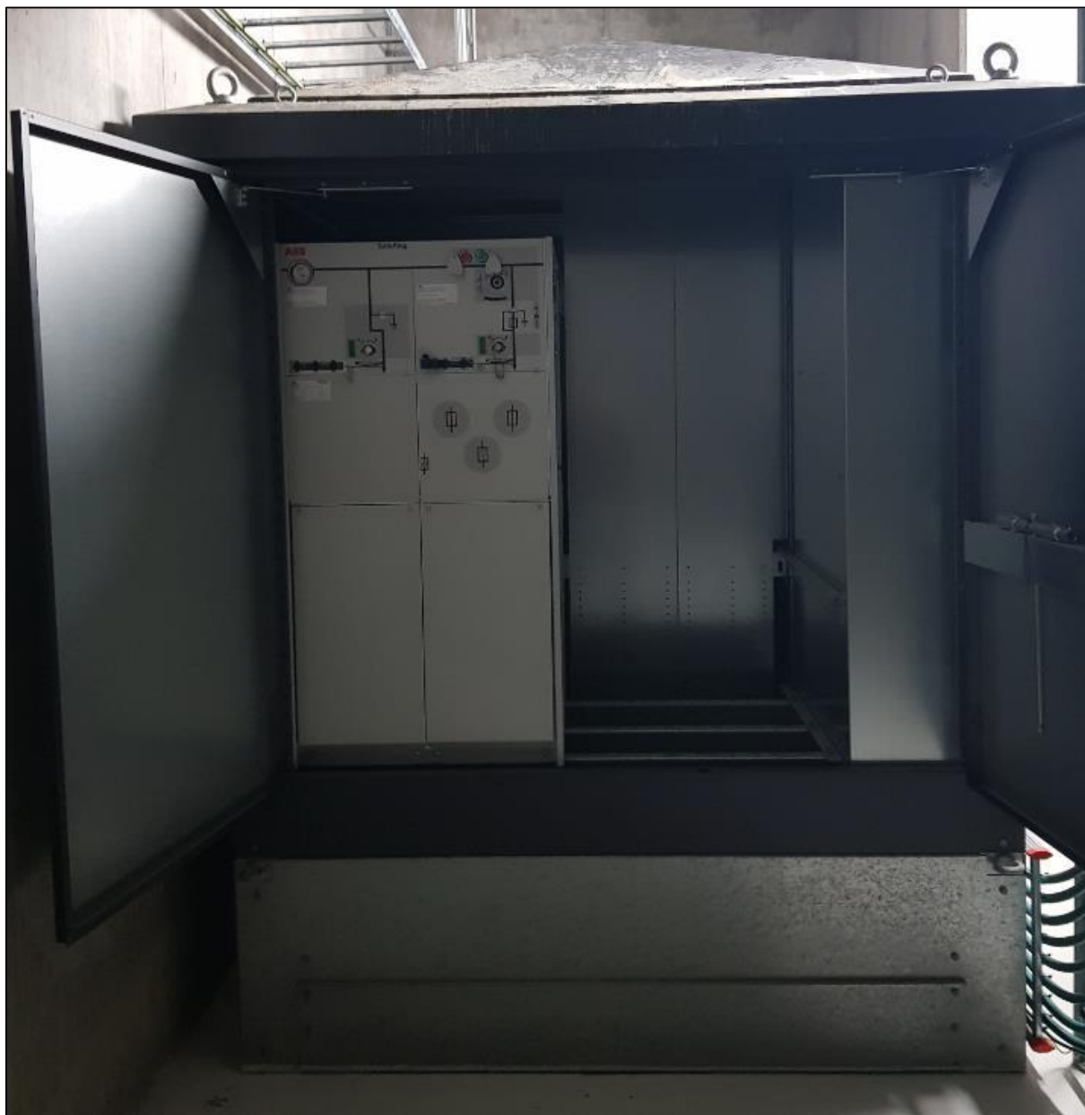
Figur 10 - Eksempelbilde av en pre-fabrikkert netstasjon montert ombord på en oppdrettsflåte
