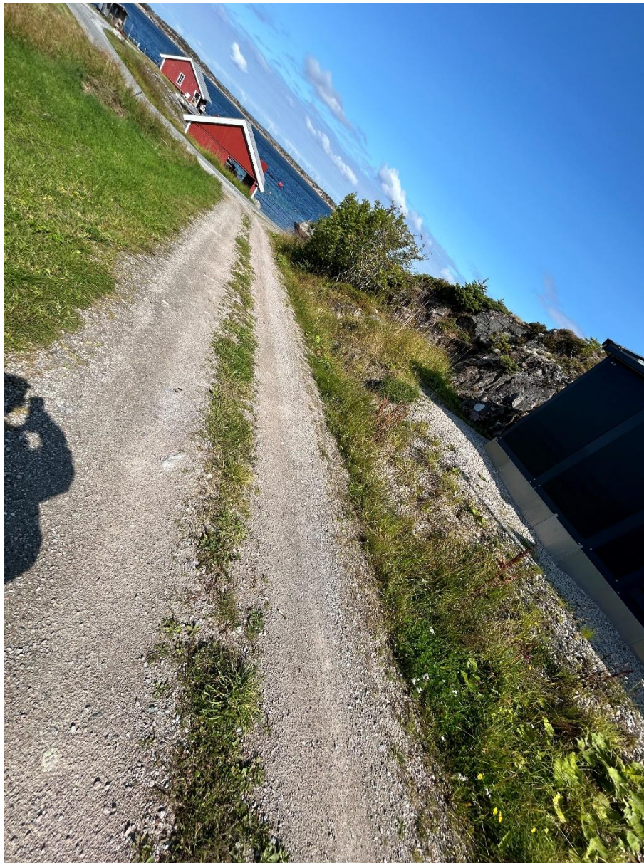
Figur 20 – Bilde kabelgrøfttrase langs vei ned mot sjø
