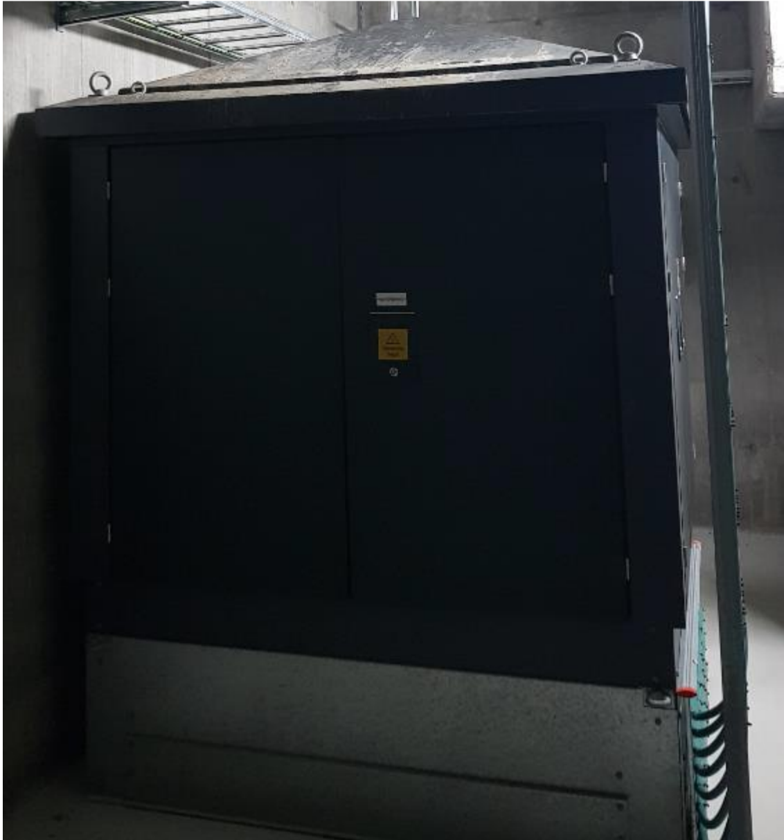
Figur 12 - Eksempelbilde pre-fabrikkert nettstasjon - høyspentdør
