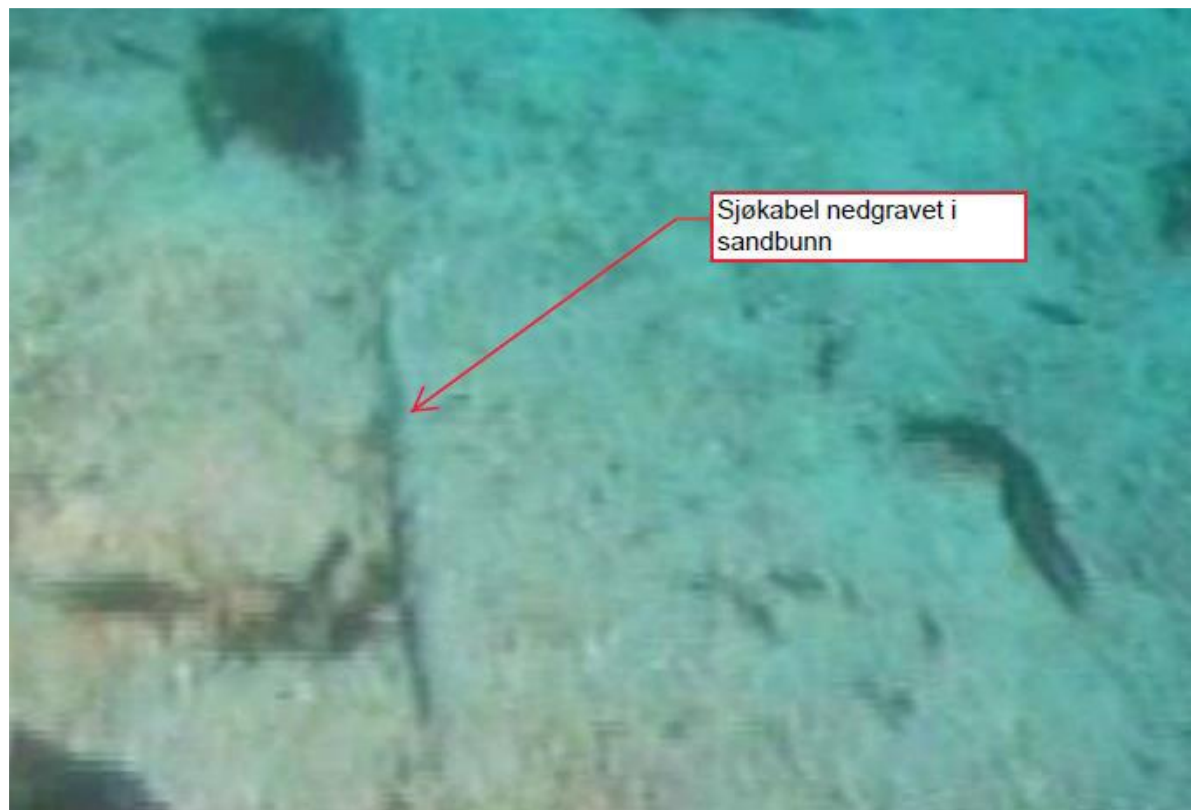
Figur 8 - Sjøkabel nedgravet/auret i sandbunnen og sjøkabel på havbunn
