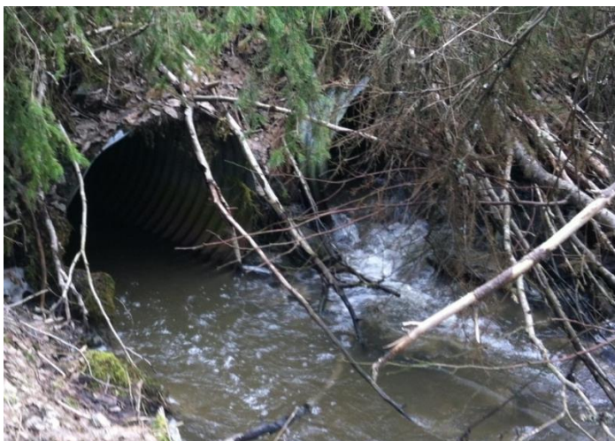
Figur 3-1: Utløp for bekkeløpet i nord
