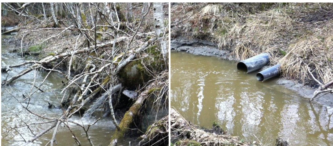
Figur 3-2: Diverse tilførselsrør langs Søra mellom utløp i nord og innløp i sør
