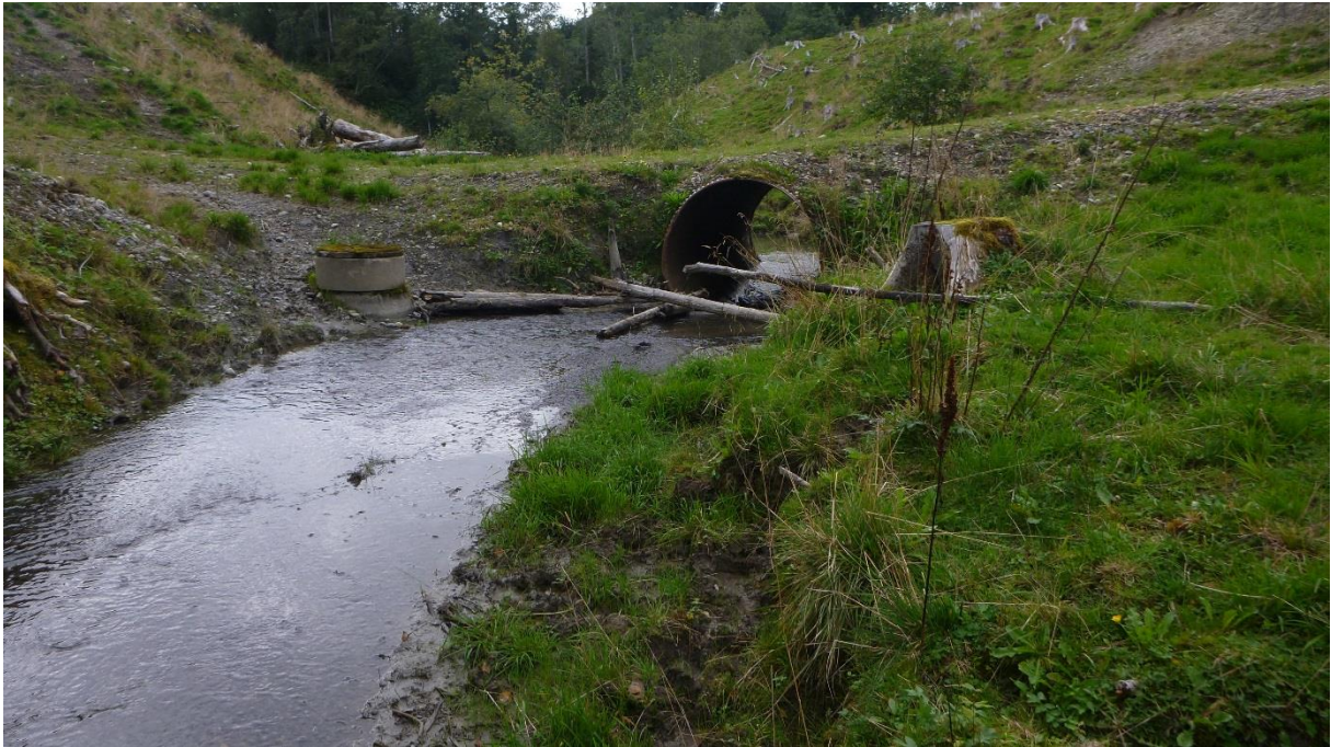
Figur 10: En traktorsti krysser Solemsbekken ved P410, og bekken er lagt i kulvert. I forbindelse med sikringsarbeidene heves veien med inntil 2 meter, og en ny kulvert anlegges her.
