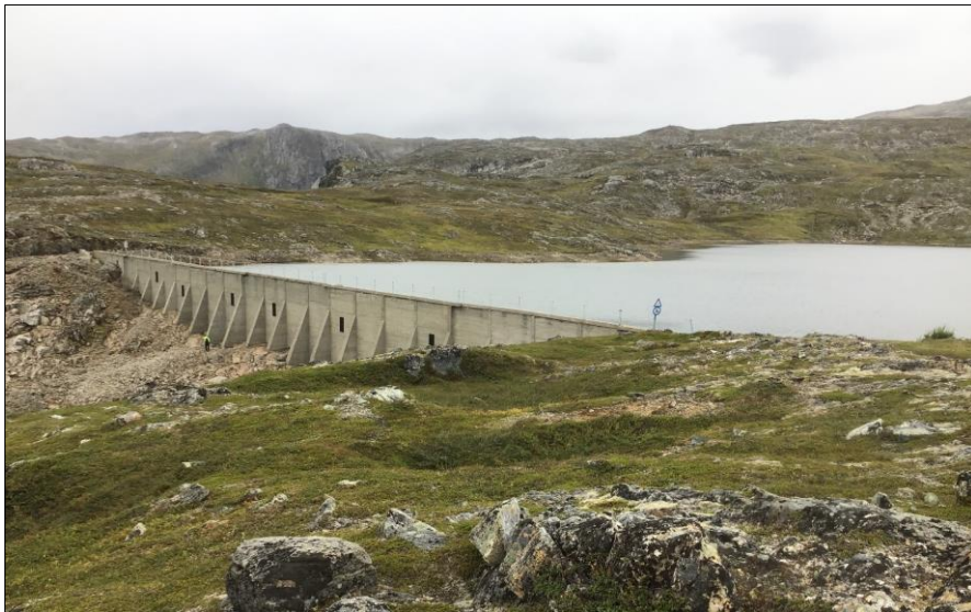
Figur 4-6: Dam ved Amundsvatn.
