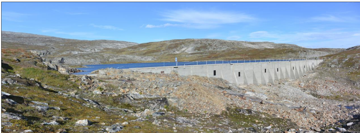
Figur 6-30: Panoramafoto av eksisterende situasjon ved dam Amundvatn.
