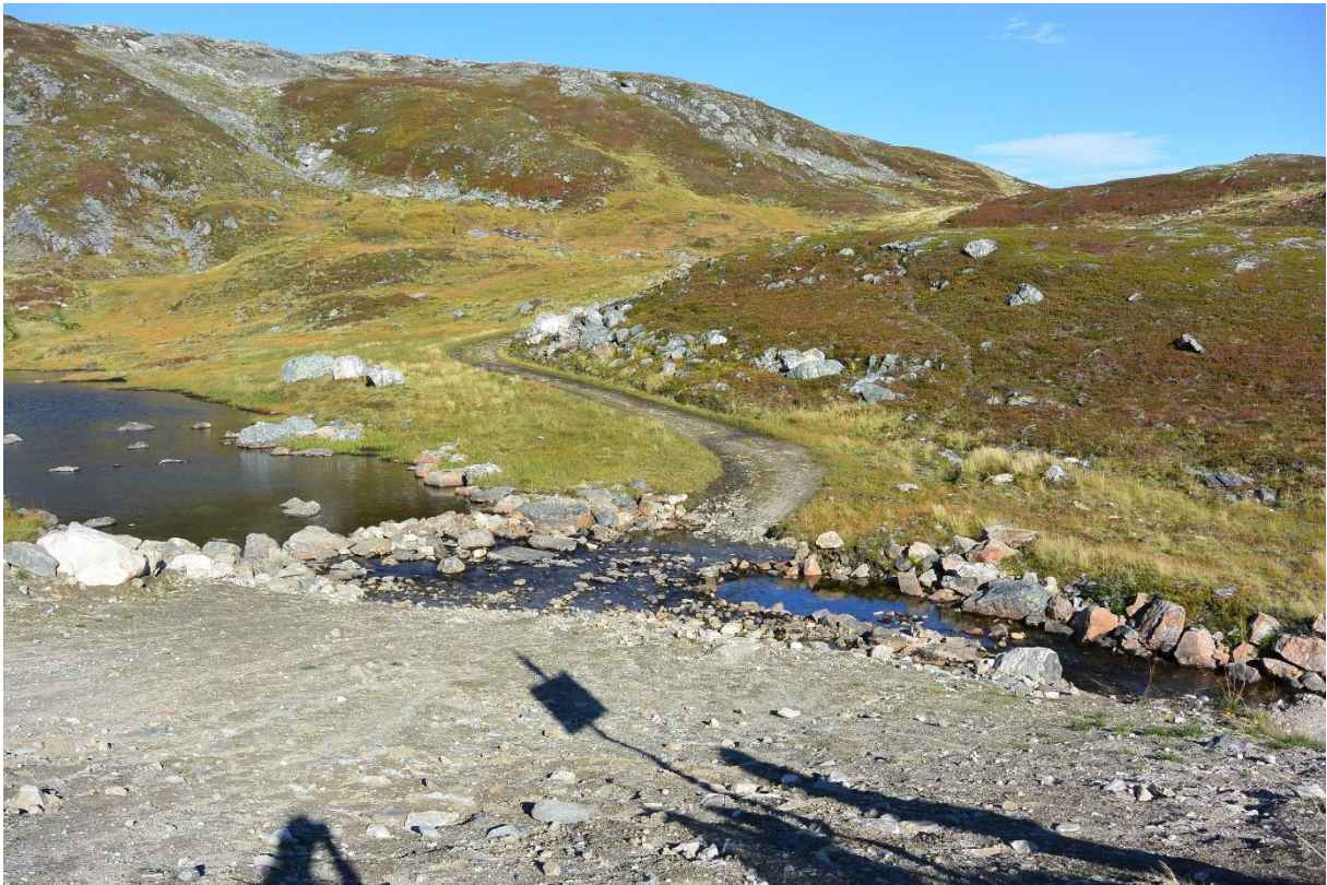
Figur 6-19: Eksisterende situasjon ved adkomstvei fra Nedrevatn til dam Amundvatn. Bildet er tatt i retning nord.
