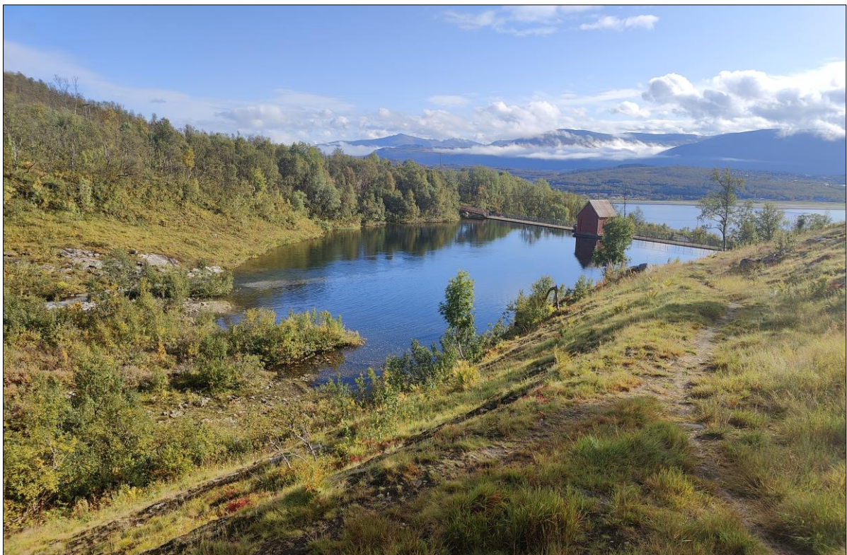
Figur 6-34: Dam Slettelva sett fra oppstrøms side.
