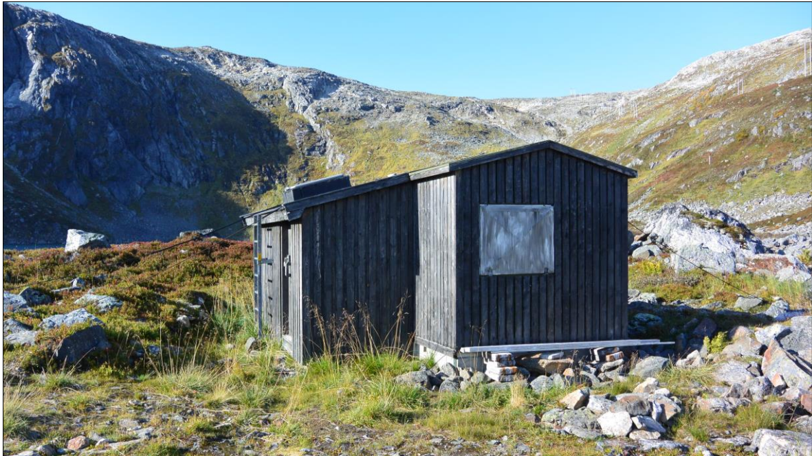
Figur 6-7: Bygning ved dammen for Svarthammervatn, tilknyttet damanlegget.
