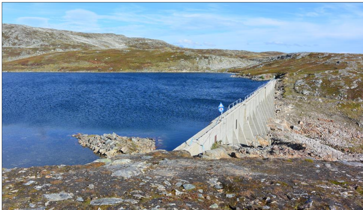
Figur 7-12: Dammen i Amundvatn. Lite vannføring nedenfor dammen. Sti østover fra vannet ses mot høyre.
