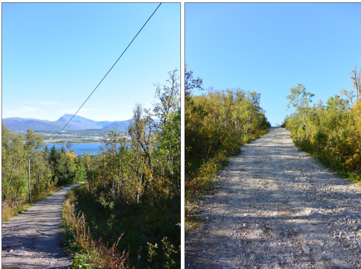
Figur 6-37: Til venstre vises deler av lysløypetrase nedstrøms Dam Slettelva. Til høyre vises deler av et brattere parti av kjøreveien opp til damanlegget.
