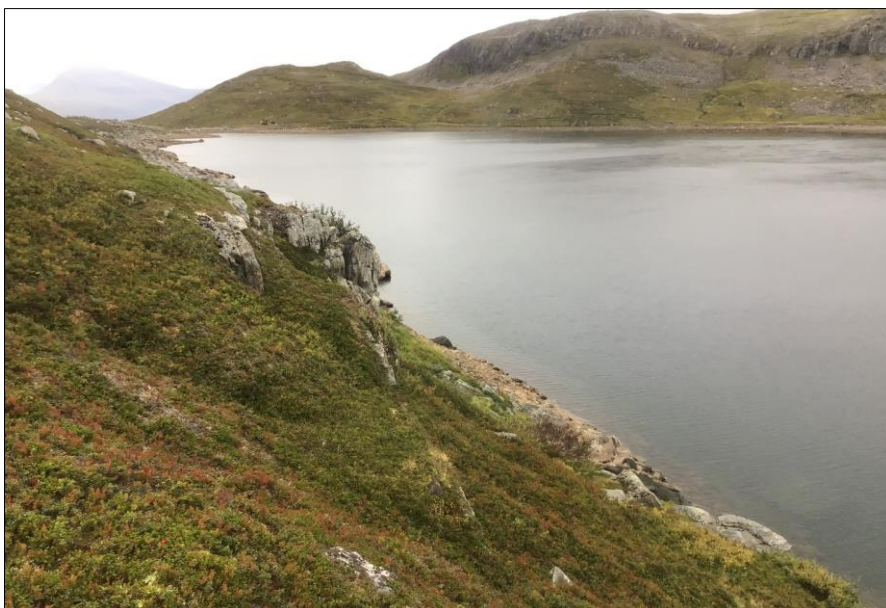
Figur 4-7: Nedre Svarthammervatn med utsikt mot dam.
