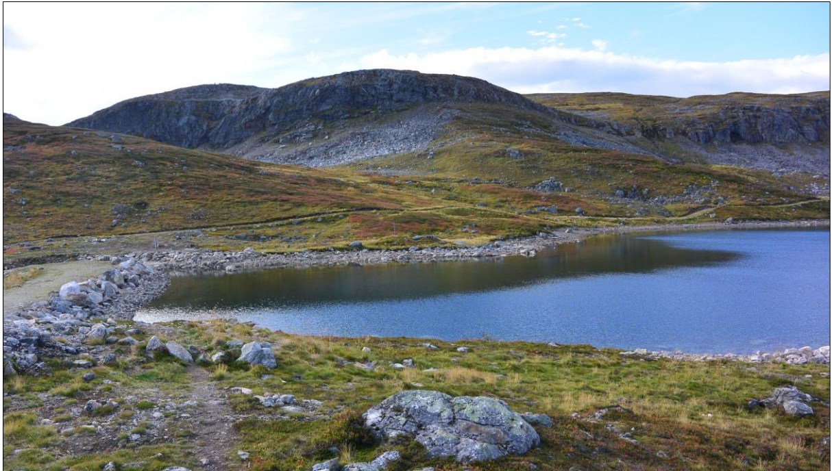
Figur 6-13: Oppstrøms dammen for Nedre Svarthammervatn. Dammen kan sees til venstre i bildet.
