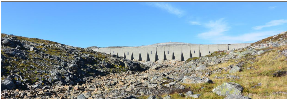
Figur 6-23: Foto tatt nedstrøms dam Amundvatn.
