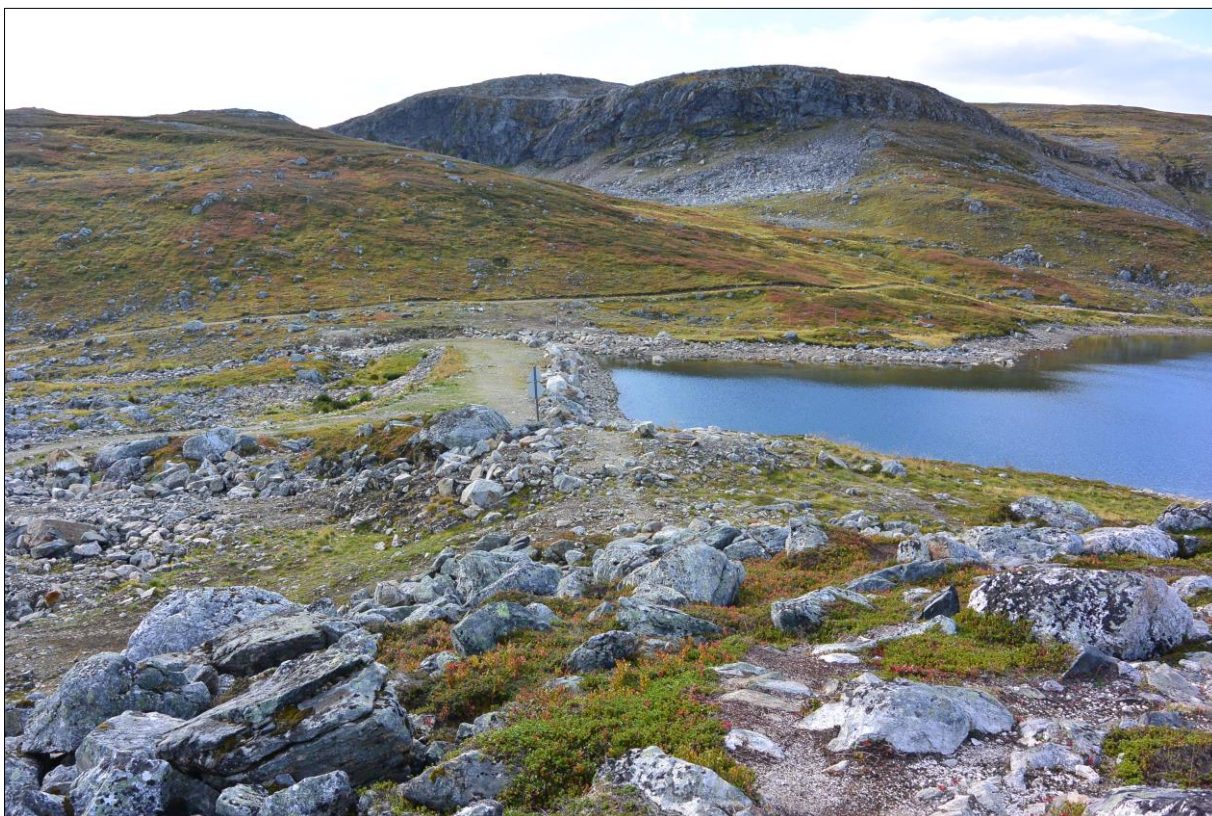
Figur 6-17: Eksisterende situasjon ved dammen for nedre Svarthammervatn. Bildet er tatt i retning sør.
