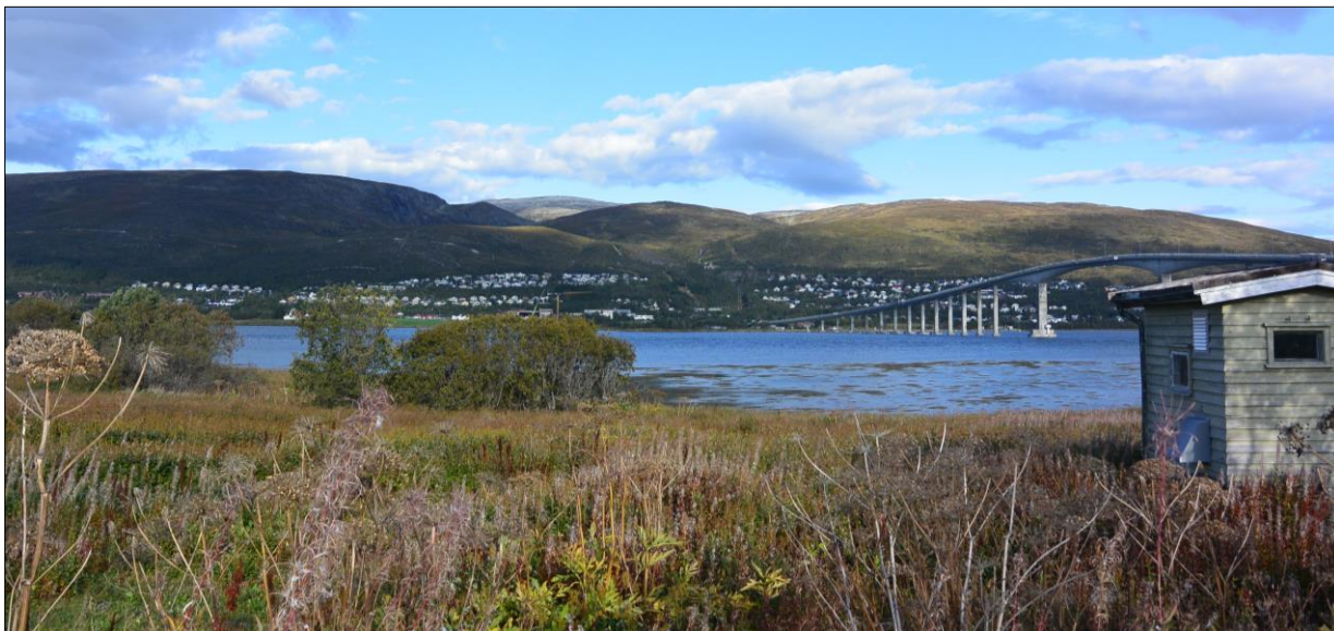
Figur 6-42: Foto fra Grindneset som viser dagens situasjon for eksisterende veitrase opp til dammene.
