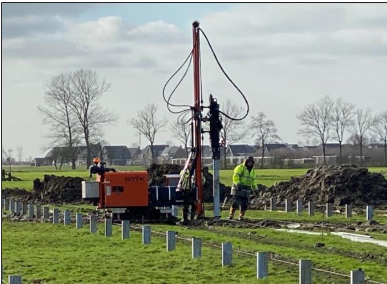
Figur 2. Eksempel på pælemaskin en-akset følgestruktur solkraftverk. Foto: Energeia.
