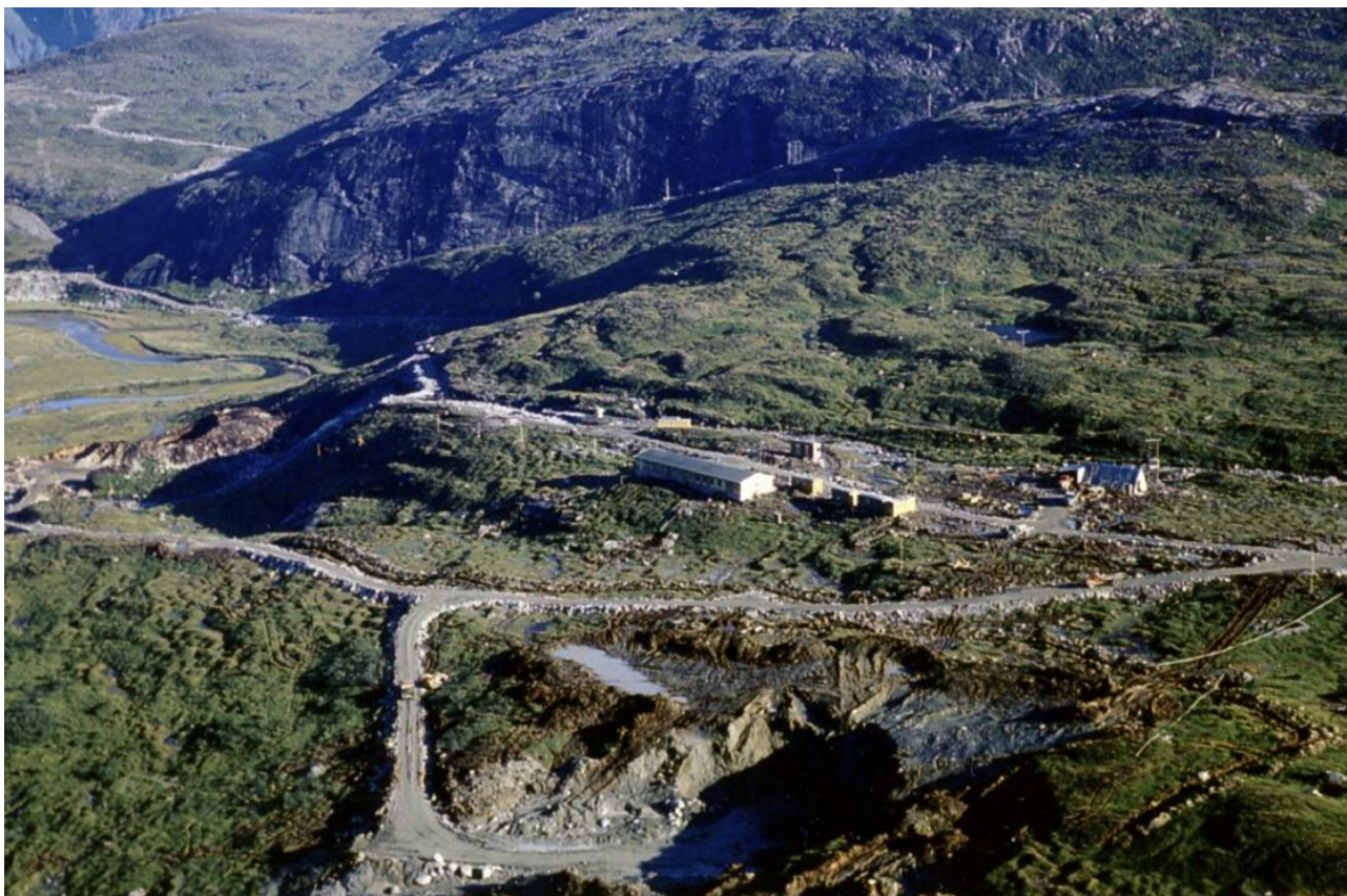
Figur 3-15. Bilete frå tidleg 1960-tal av anleggsområdet like nedstrøms Tyssevatnet. Bilete syner bl.a. det gamle morenetaket og veggnettverket på fjellet som framleis ligg der.
