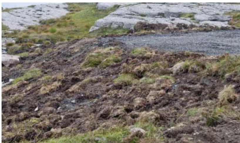
Figur 3-19. Torv og toppmassar er her ikkje klappa til. Dette vil gi raskare reetablering av vegetasjon.
