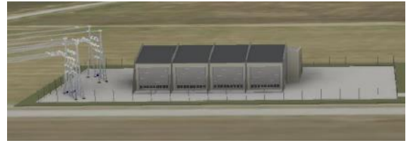
Figur 2-4 Prinsippskisse av kapslet, gassisolert (GIS) transformatorstasjon.
