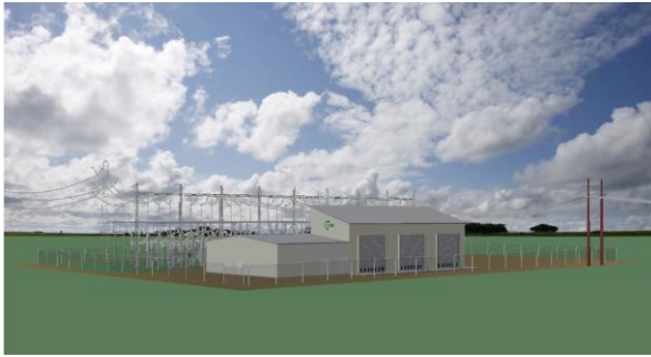
Figur 2-3 Prinsippskisse av utendørs, luftisolert (AIS) transformatorstasjon.
