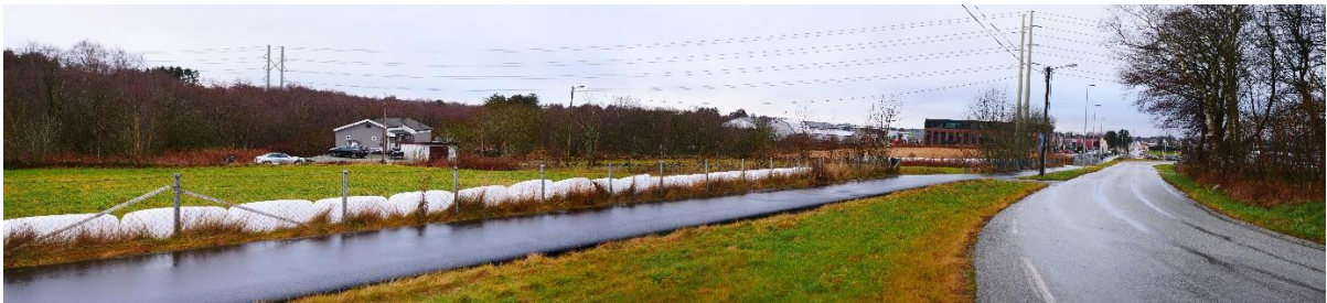
Figur 6-25 Bilde F14V11 - Randabergveien v/E39 mot vest (Tess). Trasè 2.0A
