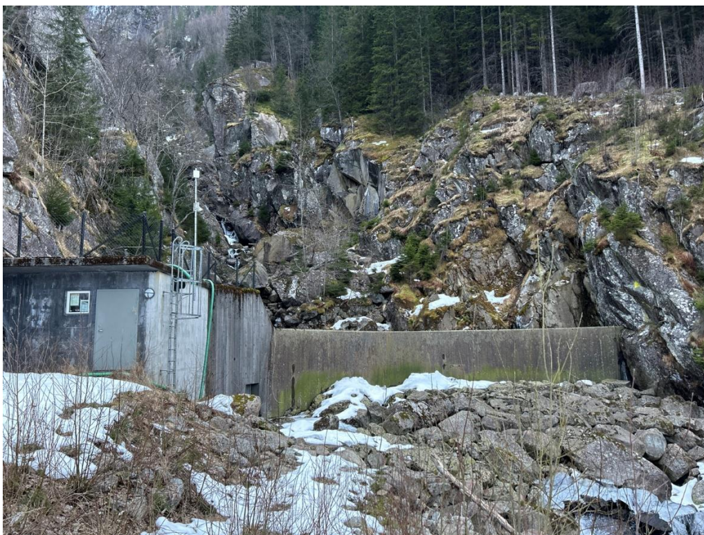
Figur 5-90: Demningen befart til fots.
