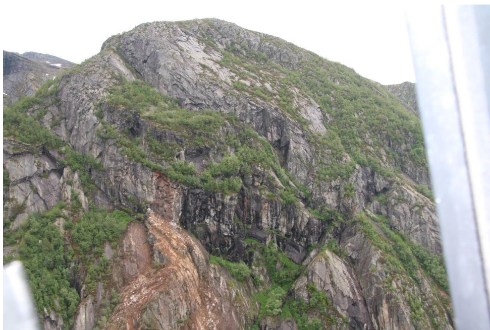
Figur 2-11: Helikopterfoto etter steinspranget i 2019. Foto: Ullensvang kommune.
