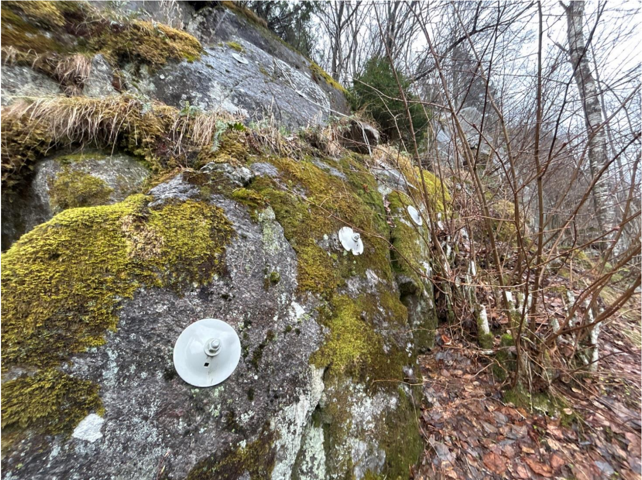
Figur 5-72: Boltesikret objekt ovenfor Ragdevegen 151 – 167.
