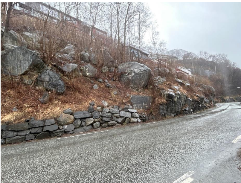
Figur 5-9: Urmassene nede for Skogen. Noen av blokkene står i fare for å remobiliseres ned på veg. Husene står på fjellterskel.
