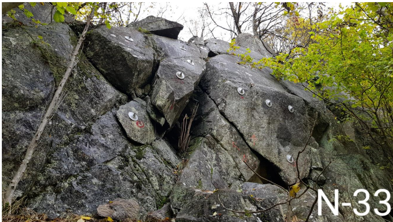
Figur 2-39: Eksempel på utført boltesikring ved lokalitet N-33.
