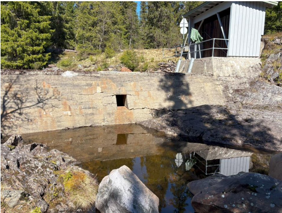
Bilde 6 Bekkeinntaket sett fra nedstrøms side
