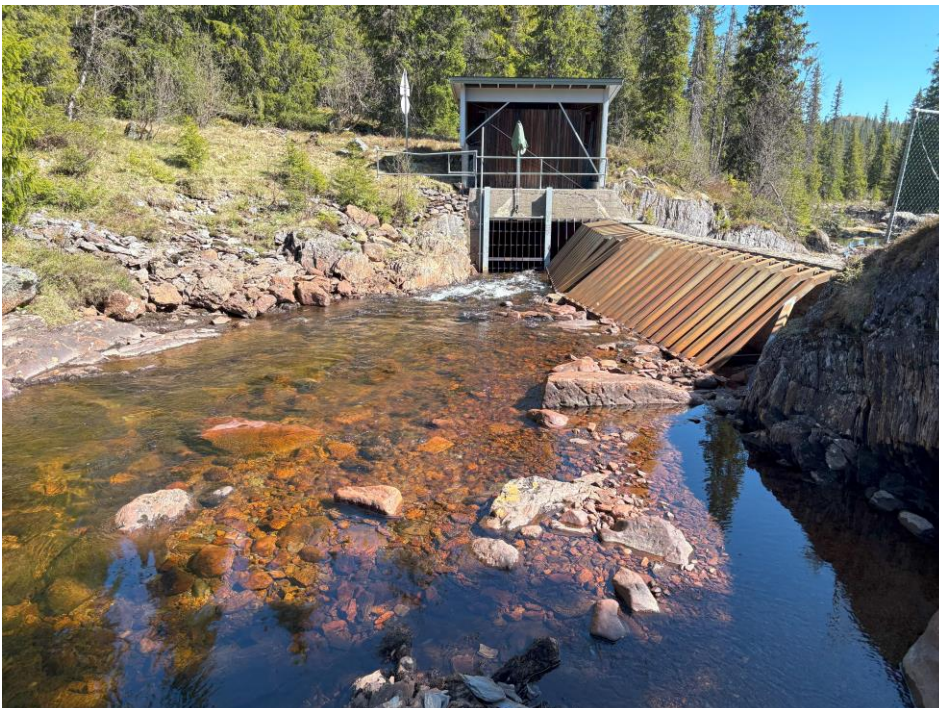
Bilde 2 Bekkeinntaket sett fra oppstrøms side, fra vest
