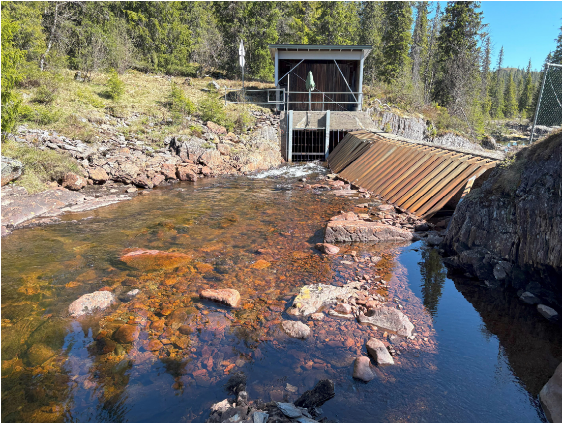
Bekkeinntak Heiåi, sett fra oppstrøms side (mai 2025)
