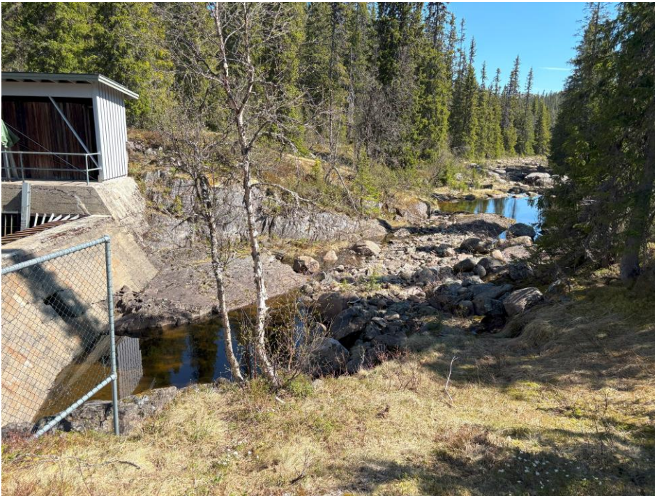
Bilde 5 Elveleiet nedstrøms for bekkeinntaket
