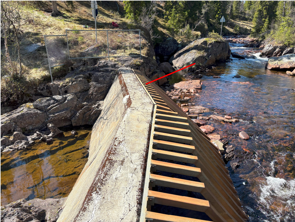
Figur 7 Rød strek viser omtrent plassering av ledevegg som skal lede tilsiget til tapperør gjennom dammen.
