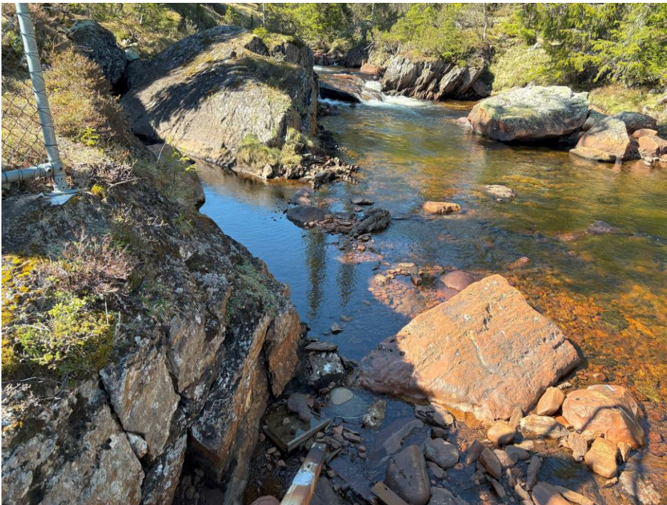
Bilde 10 Oppstrøms side der vegg for minstevannførings-arrangement kan stå
