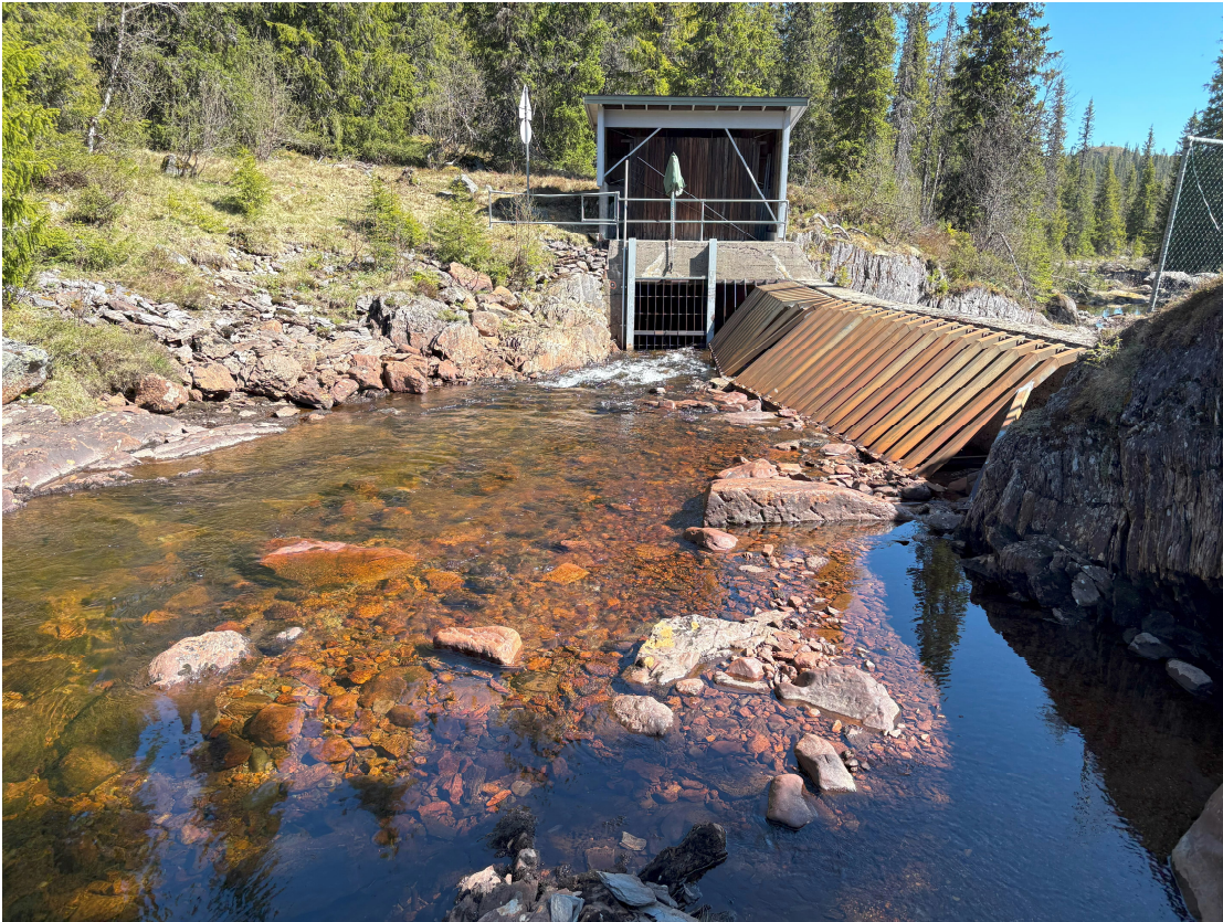
Figur 3 Bekkeinntaket sett fra høyre side, oppstrøms (mai, 2025)
