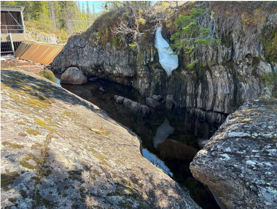
Bilde 9 Området vest for eksisterende betongterskel
