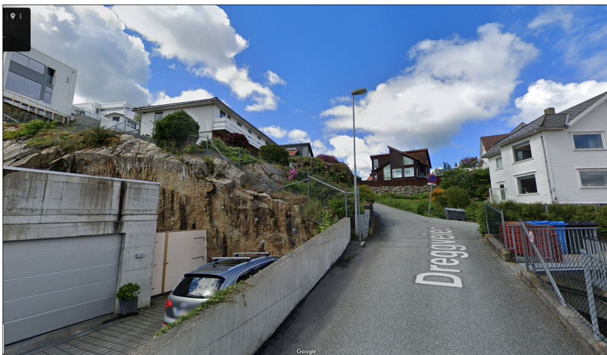
Figur 13: Bilde som viser fjell i dagen langs kritisk skråning 2, og tiltaksområdet til høyre (hvit bolig). Utklipp i retning vest-sørvest. Foto: Google Streetview.
