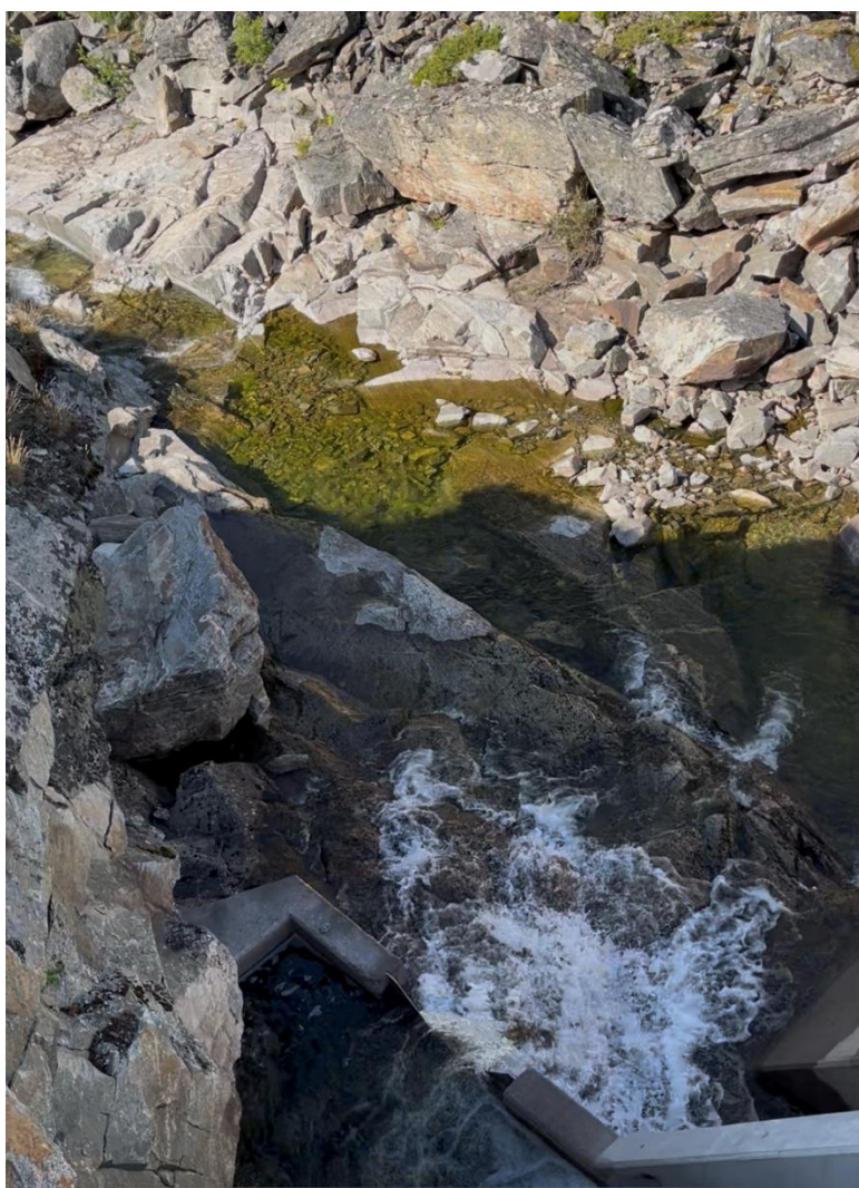
Foto 1: Minstevannføring sluppet fra betongdammen ved Mørkedøla pumpestasjon den 19. juli 2026
