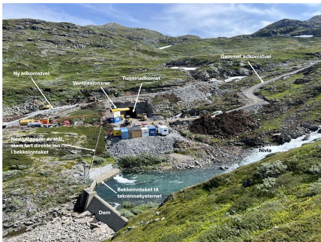
Foto 4: Bekkeinntaket i Gravdalen, sommeren 2025, tørrlagt nedstrøms (Kilde: Moe & Moe 2026) 8
