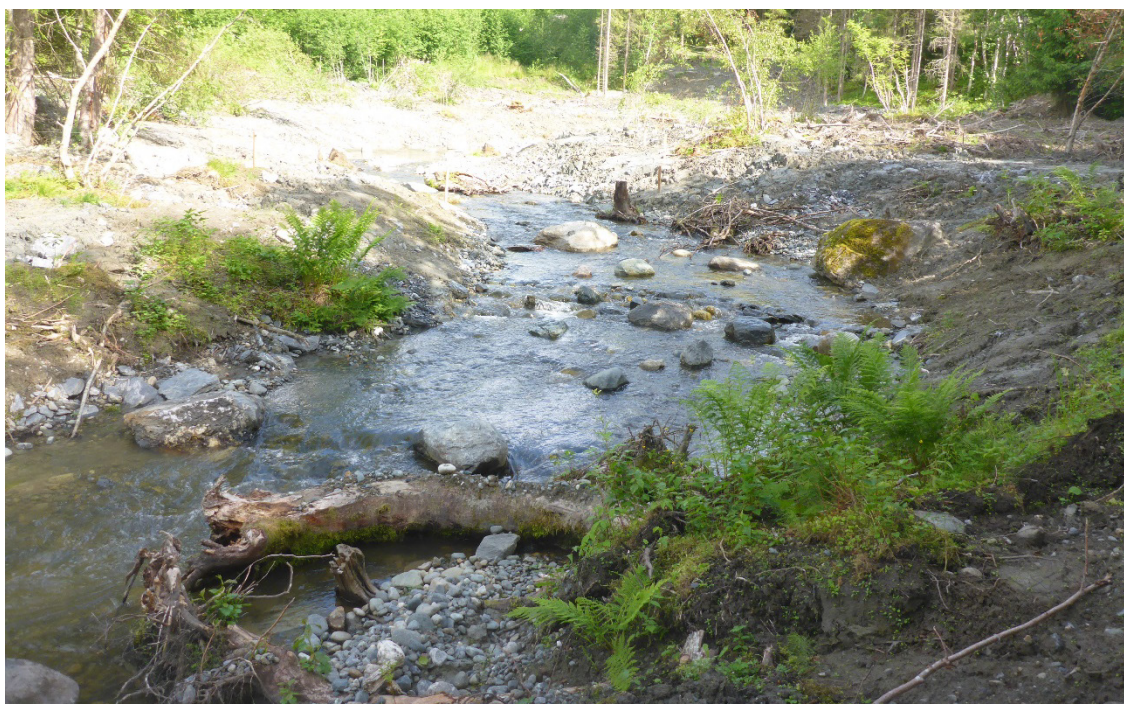
Figur 7-3: Fra midtre del av Hofstadelva etter sikringsarbeidet er gjennomført
