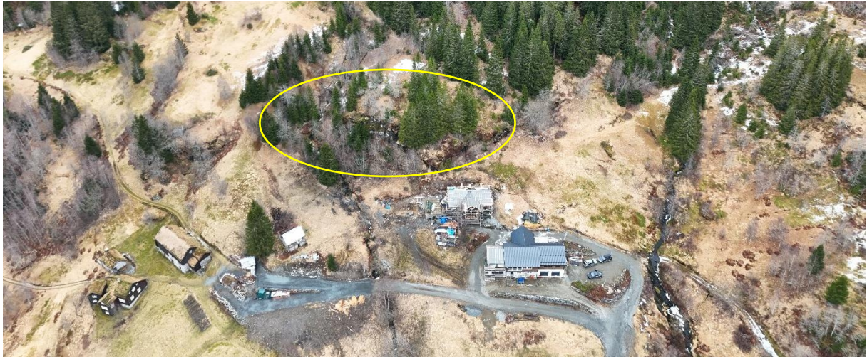
Figur 4: Oppstikkende berggrunn (gul ellipse) som er mest relevant for skredfaren i kartleggingsområdene er synlig i nedre del av dalsida og framstår for det meste som lite oppsprukket, uten ferske merker etter utfall av bergblokker. Bildet er tatt mot NØ.
