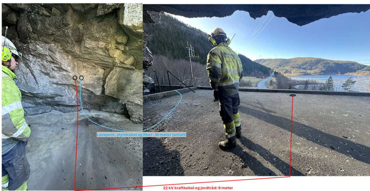
Figur 4: Kabelføring over tak av portalbygg.
