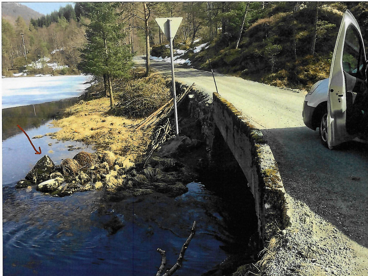
Bilde 2. Viser rimelig stor vannføring i elven. Se rød pil på toppen av steinen, hvor toppen av denne steinen ligger 12 cm under topp ferdigstøpt demning
