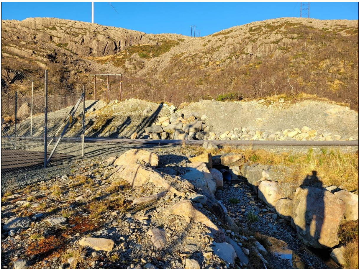
Figur 27: Bekk som går langs austre grense til eksisterande transformatorstasjon. Bekken er lagt i røyr under tilkomstveg. Biletet er tatt mot nord. Infopunkt 30.
