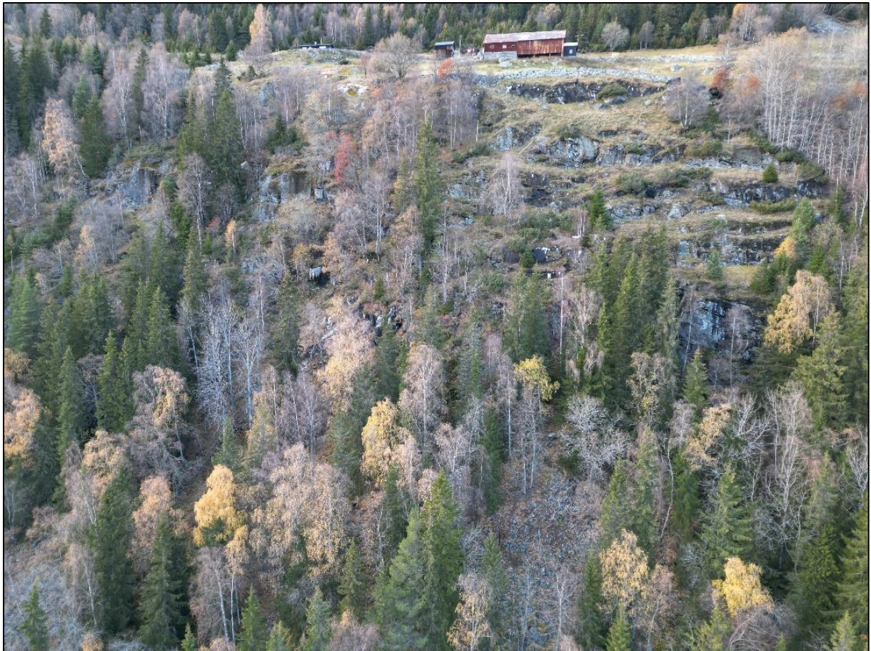
Figur 13: Skreenter mellom Bekkestad og Djupedokki. Bildet er tatt mot nord, med drone på befarings.
