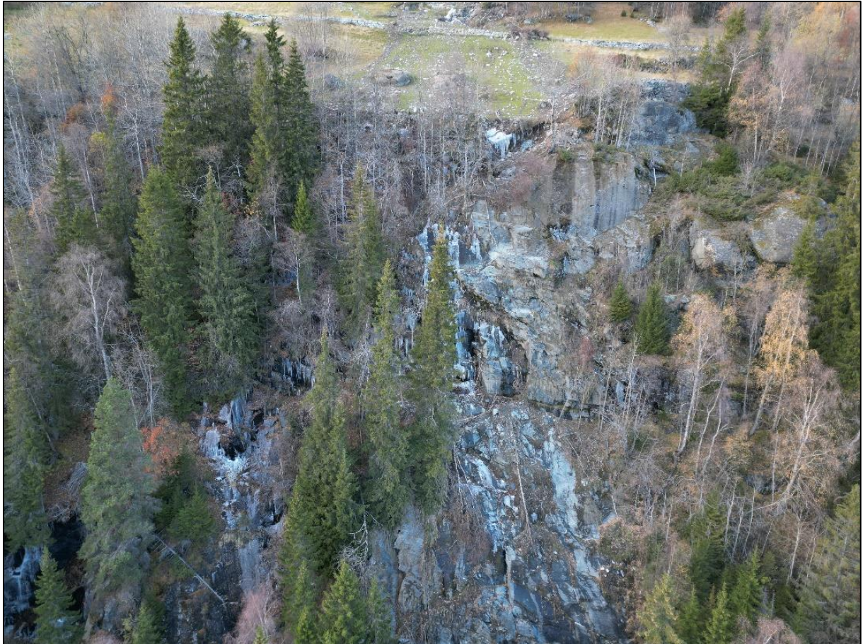
Figur 12: Skreenter, løснеområder for steinsprang, mellom Bekkestad og Djupedokki. Bildet er tatt mot nord, med drone på befaring.
