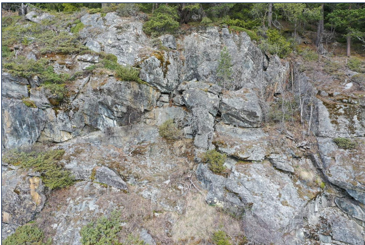
Figur 5: Bildet viser skrent med delvis avløste blokker og årlig sannsynlighet for steinsprang større enn 1/100, ovenfor Tunehago. Bildet er tatt med drone på befaring, mot nordvest.
