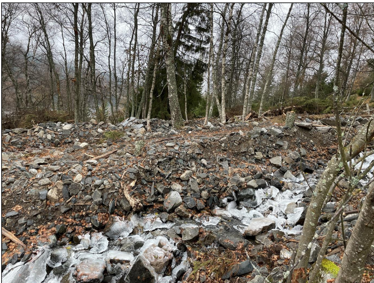
Figur 9: Bildet viser at det foregikk masseførende flom ved Sundbreigrove under "Hans". Bildet er tatt i oktober. Bildet er tatt like ovenfor rotpunktet til vifta.
