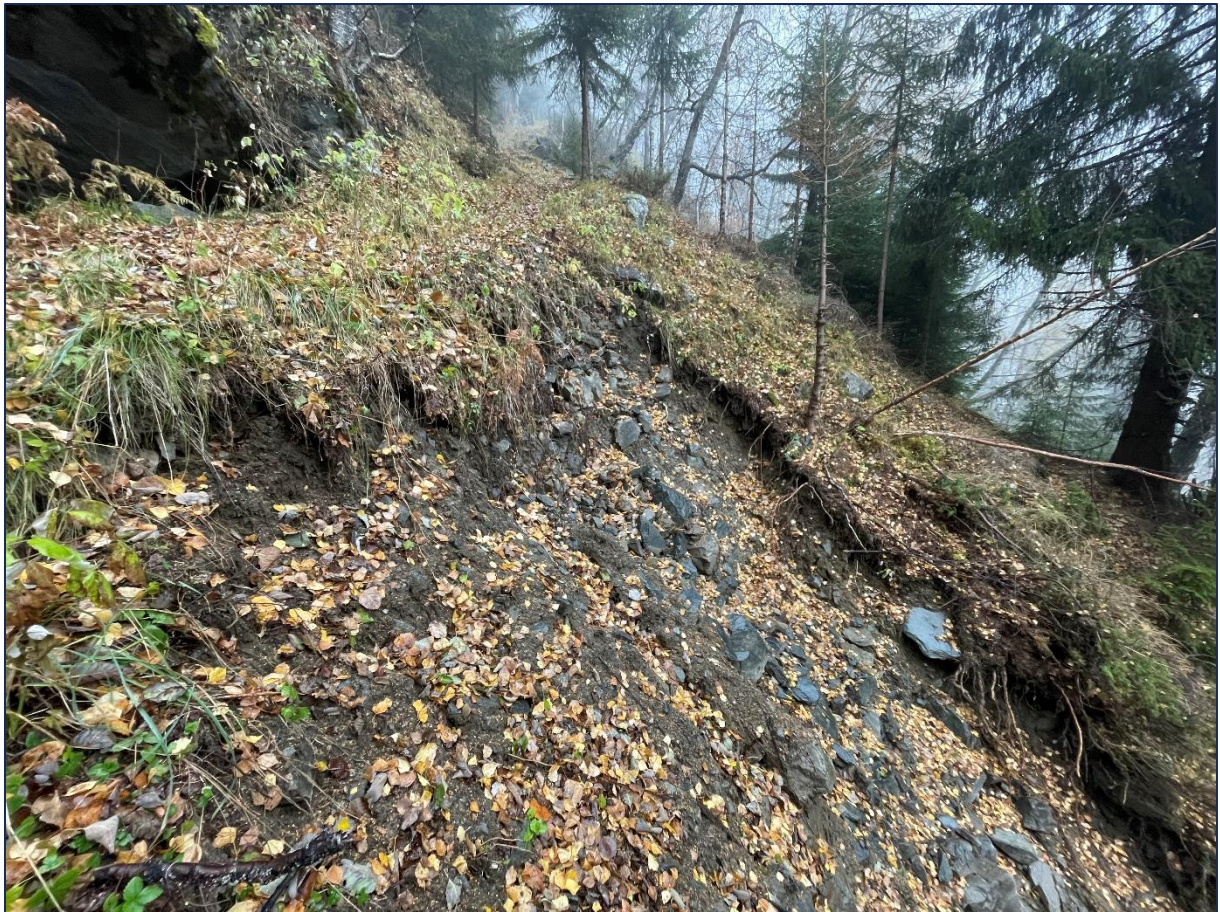
Figur 2: Bildet viser skredsåret til Eikra vest (ID8). Skredet løsnet i en turveg.
