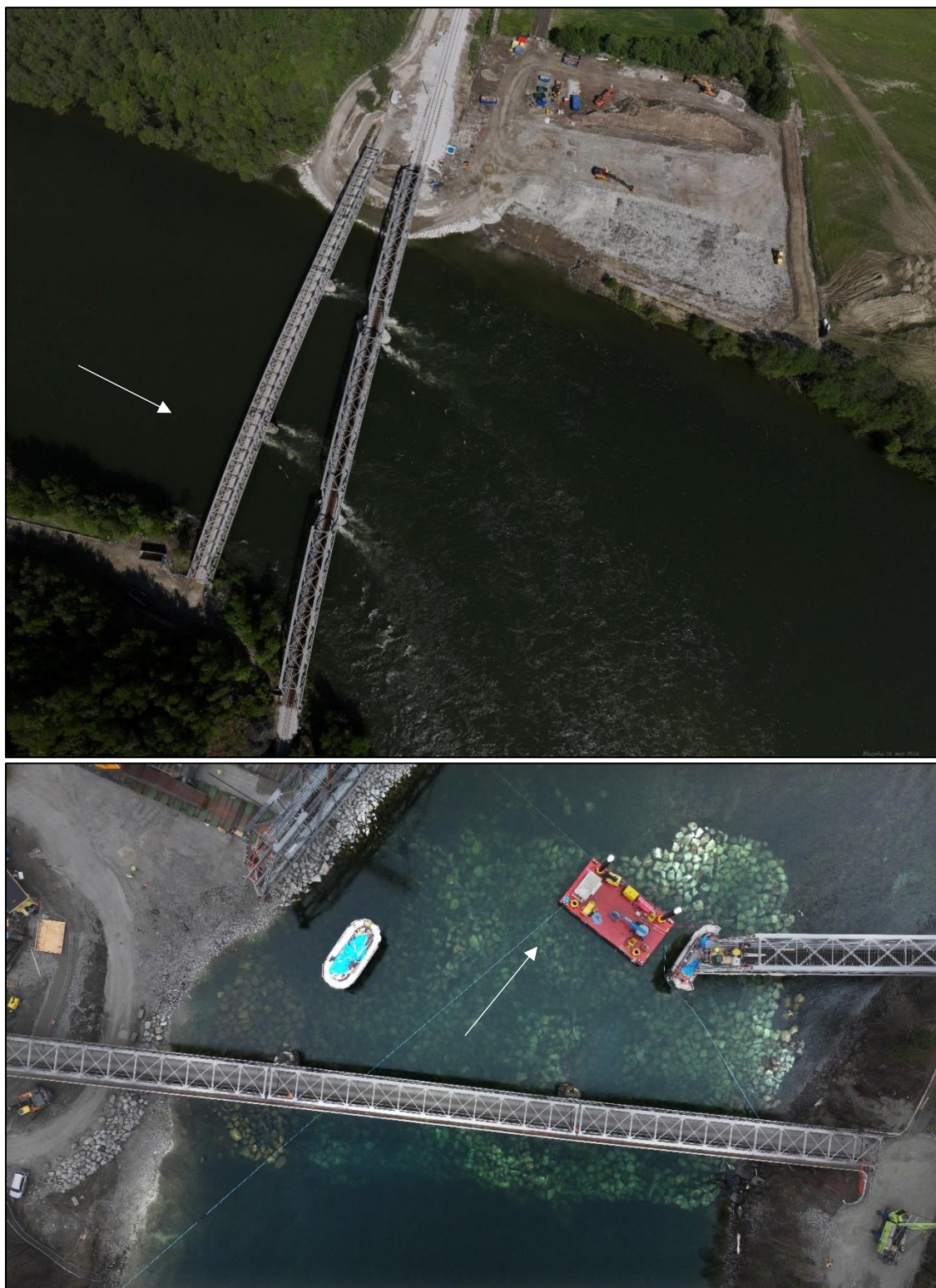
Figur 2-2. Dronebilde av tiltakets status per 24. mai (øverst) og 27. april (nederst) 2024, der sistnevnte viser ferdig erosjonssikring med blokksteiner på elvebunn. Strømretning er indikert med hvit pil. Et samlet areal på om lag 5000 m 2 er plastret med stor blokkstein på elvebunn under Randklevsbruene og området nedstrøms. Foto: K. Rolseth.
