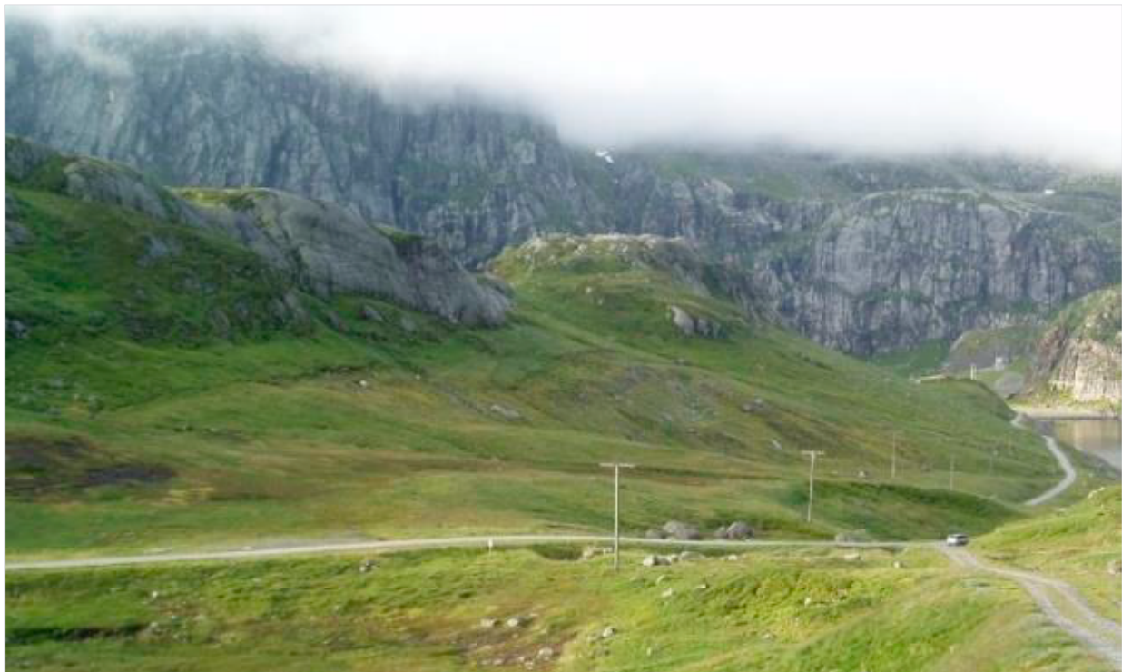
Figur 22. Statkraft planlegger å bruke tilsvarende master som på bildet for ledningen i Blådalen, muligens med doble stolper. Bildet er hentet fra tilleggsutredningen.
