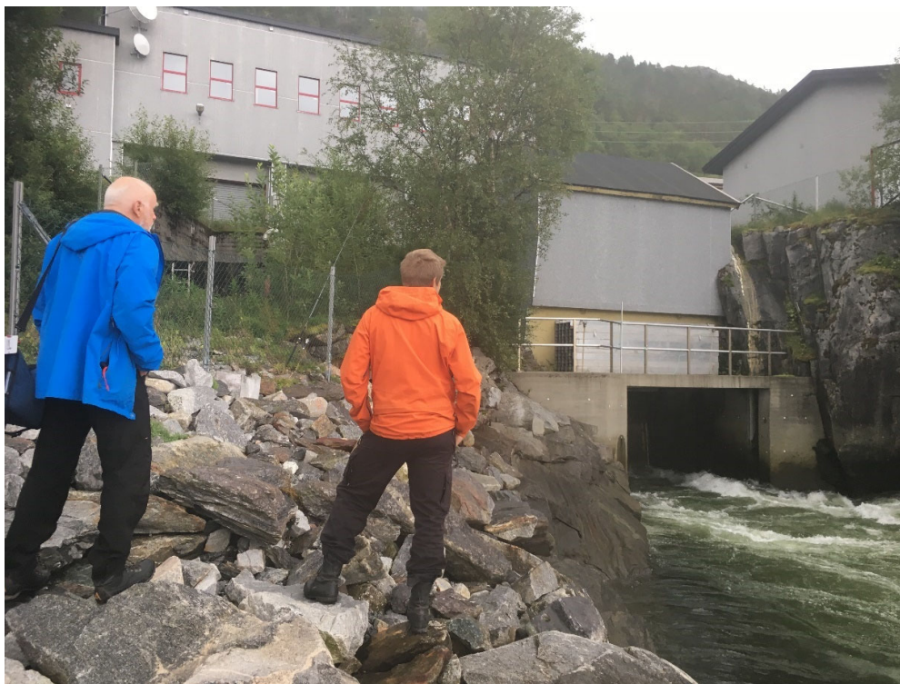
Figur 4 Grytåga kraftverk har utløp direkte i sjøen.
