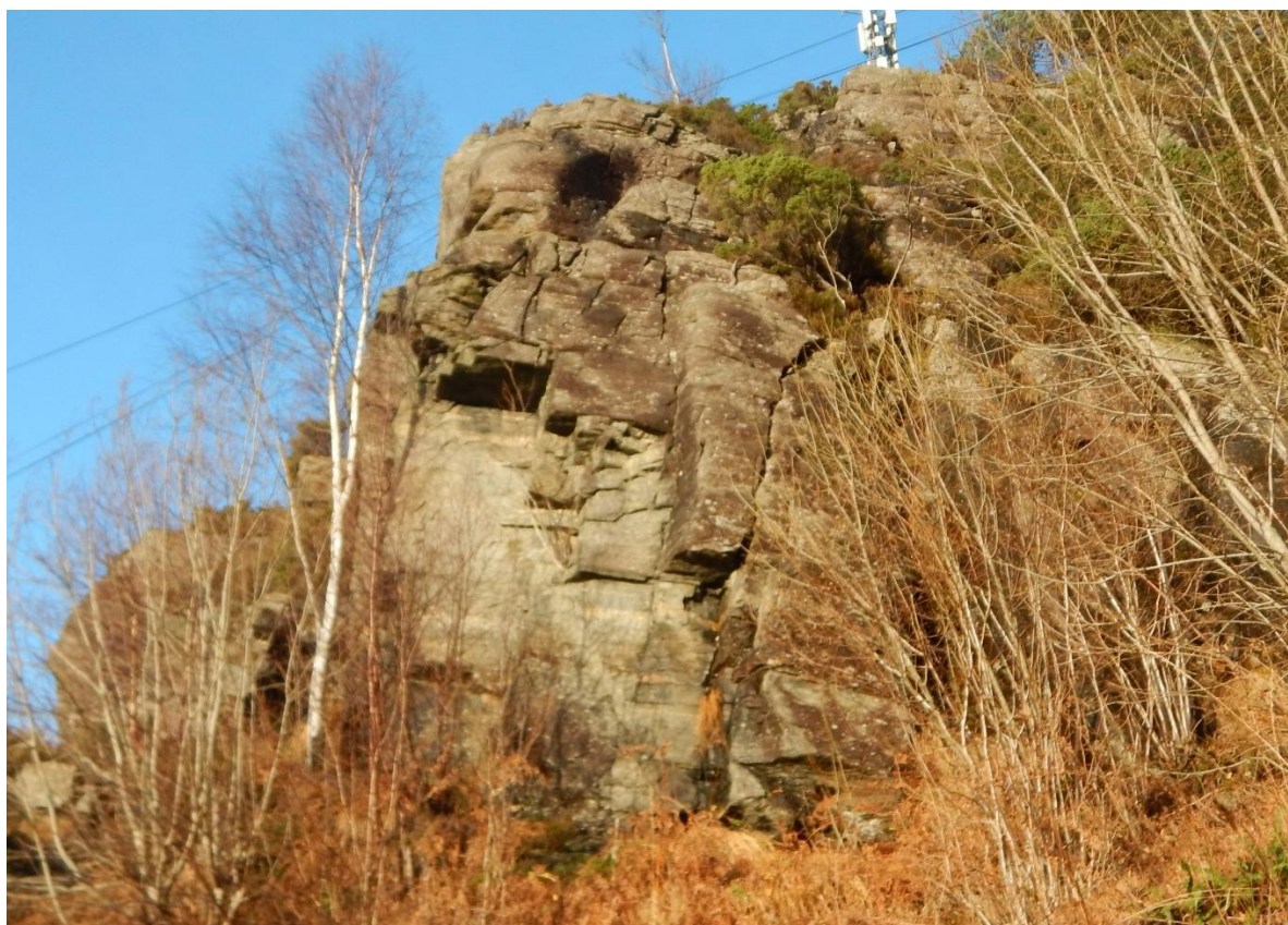
Figur 4: Parti av bergskrenten nordvest for boligen som har enkelte delvis avløste partier.
