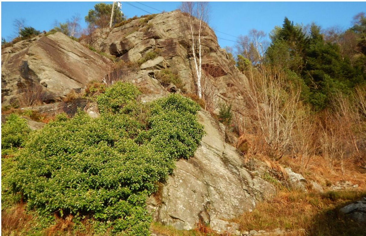
Figur 3: Bildet (tatt mot NØ) viser typisk del av bergmassen i skrentene bak boligen. Bergoverflata er i all hovedsak iserodert og godt forvitret, men også enkelte avløste partier som også er godt forvitret. Skyggen av boligen kan ses i høyre bildehjørne.
