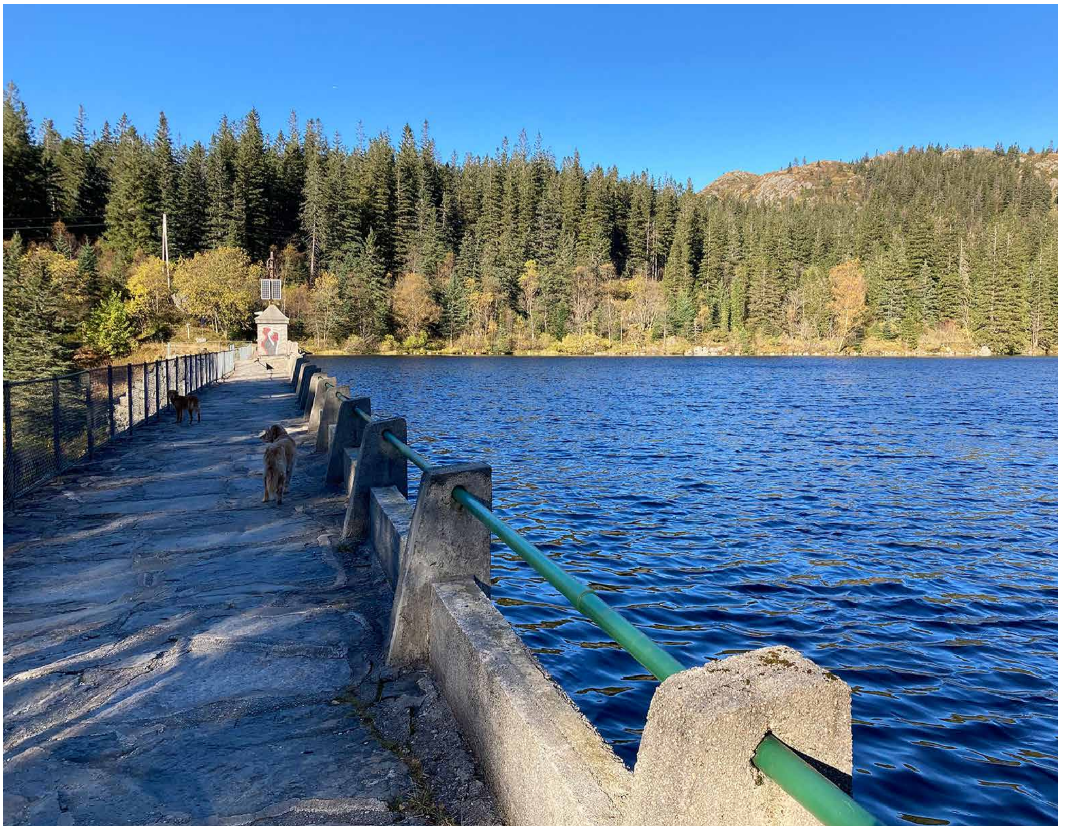
Dam Storediket er en turdestinasjon for mange. Bildet viser hvordan demningsbroen går i flukt med vannet.
