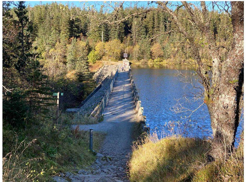
Demningsbroen går i flukt med vannet
